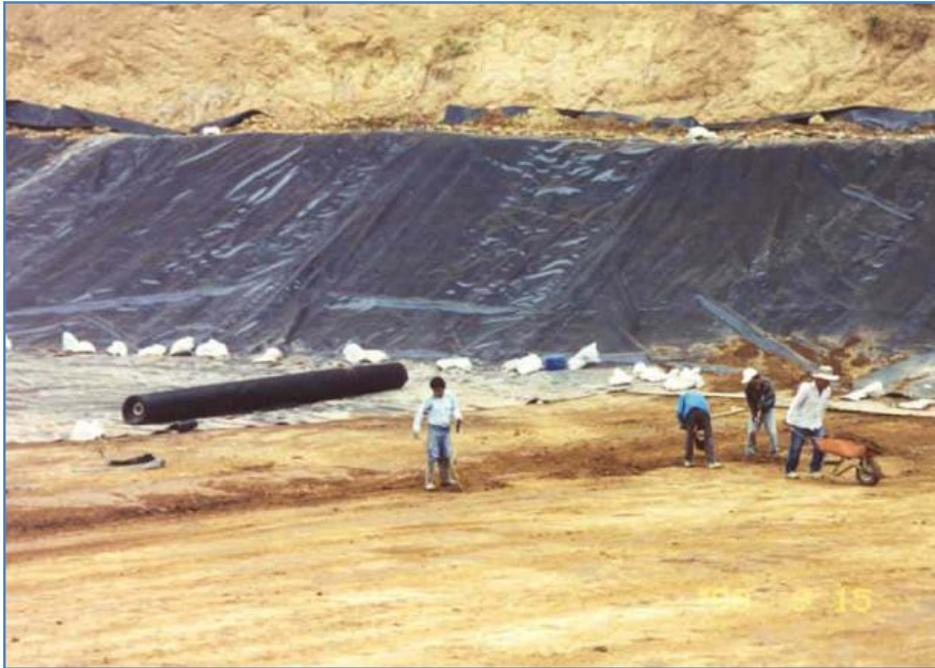
**Figura 1.11 Preparación de un sitio de disposición
