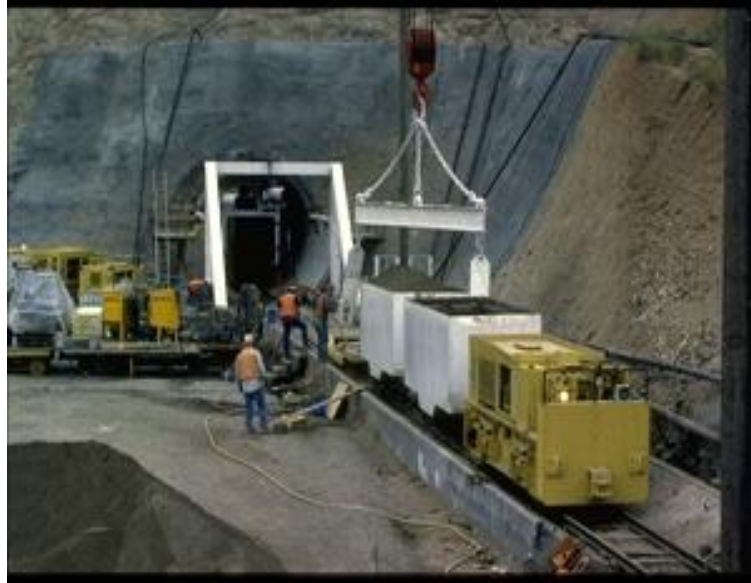
Figura (66) método de extracción de la rezaga mediante vagonetas
