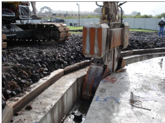
Figura (49) excavación del tablero
