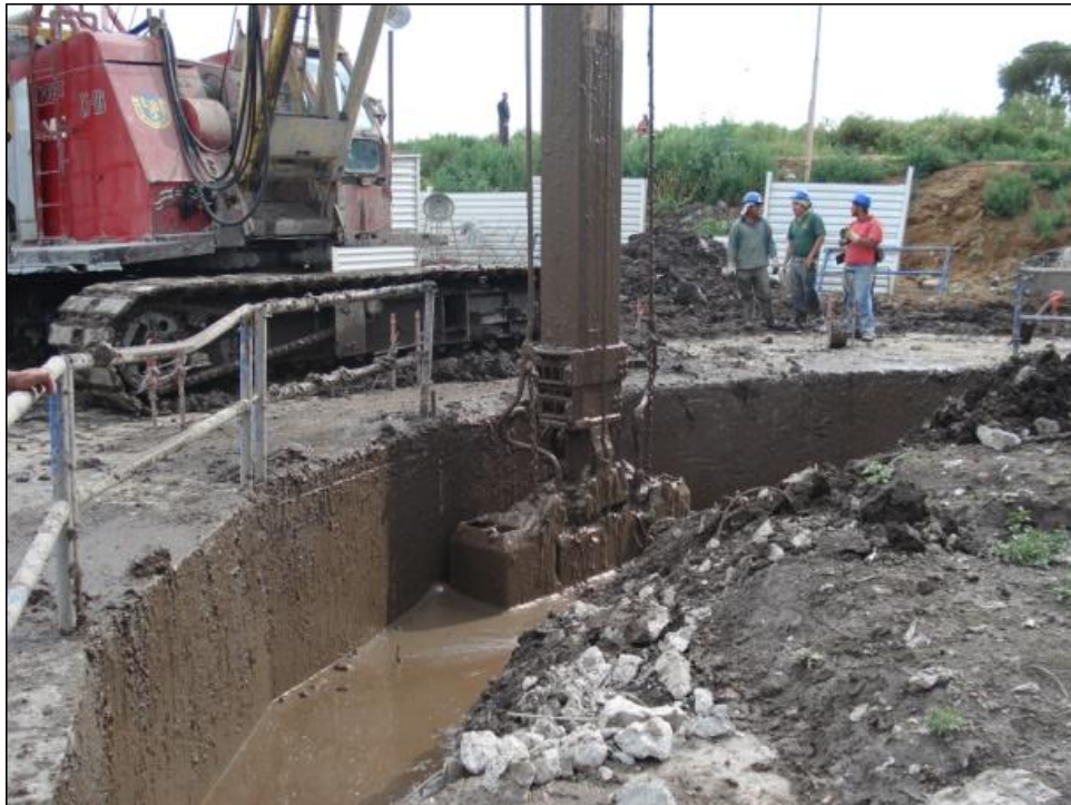
Figura (51) excavación de la zanja perimetral
