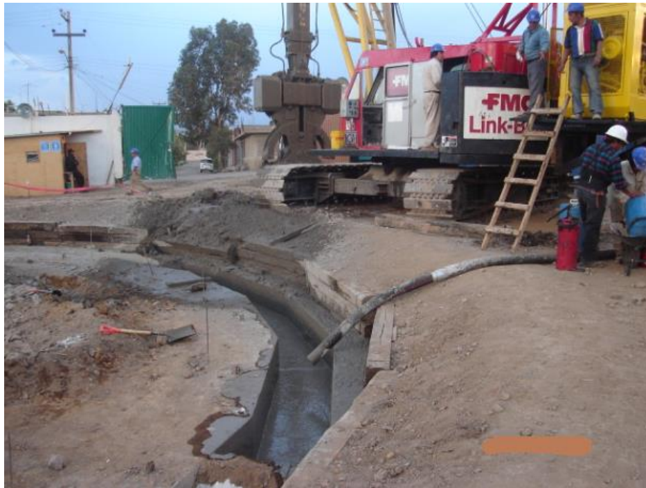
Figura (50) colocación de lodos bentoniticos para estabilizar el terreno
