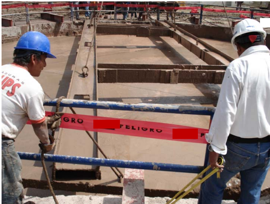
Figura (54) verificación del diámetro excavado
