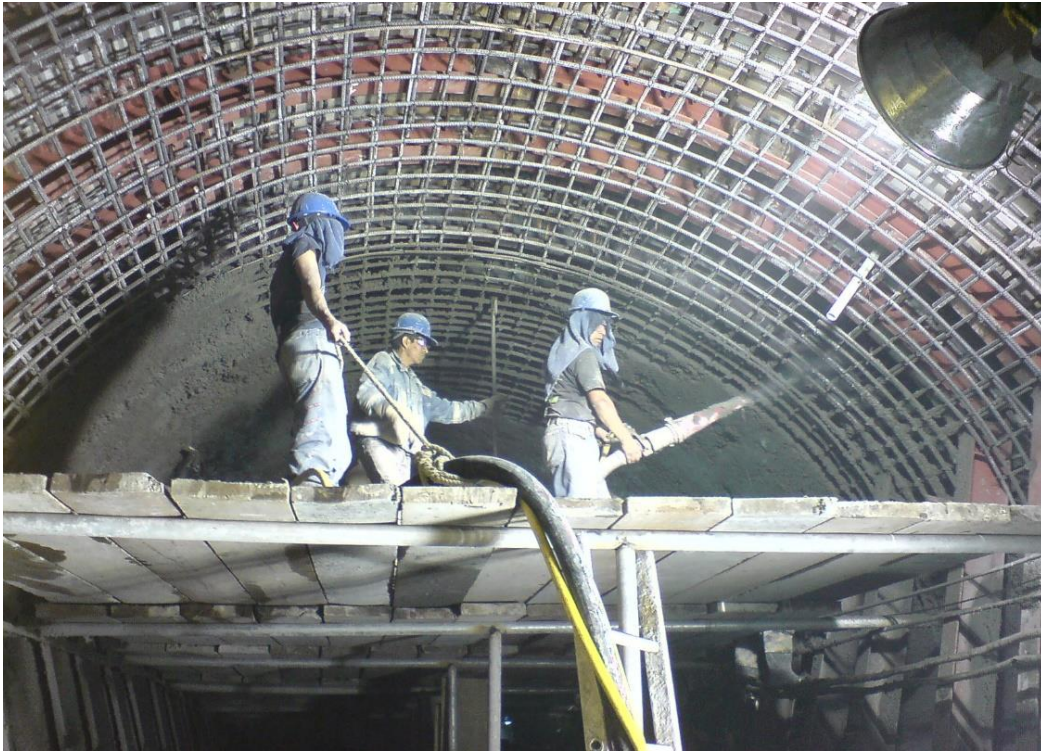
Figura (89) concreto lanzado
