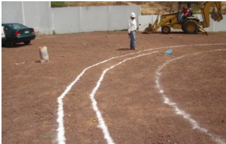
Figura (43) trazo de brocal sobre terreno
