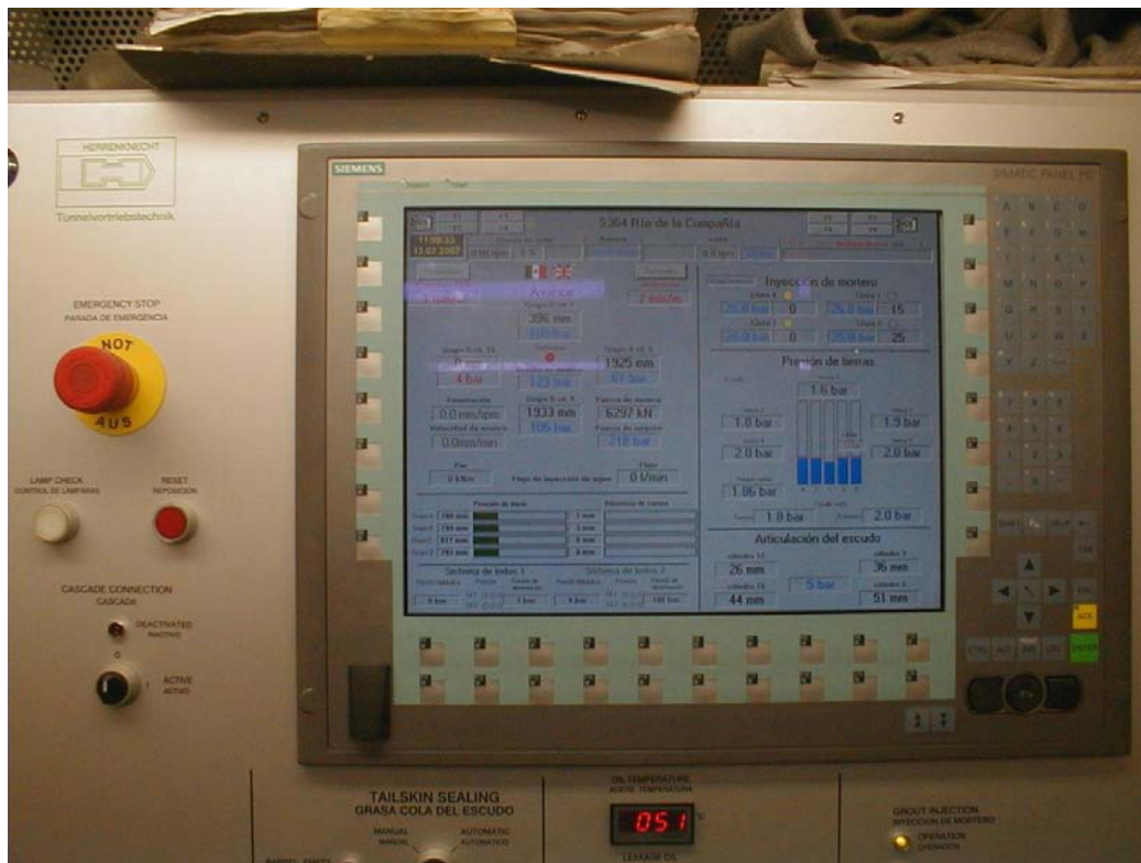
Figura (37) mediante un programa permite al operario monitorear y controlar todas las funciones de tuneleo
