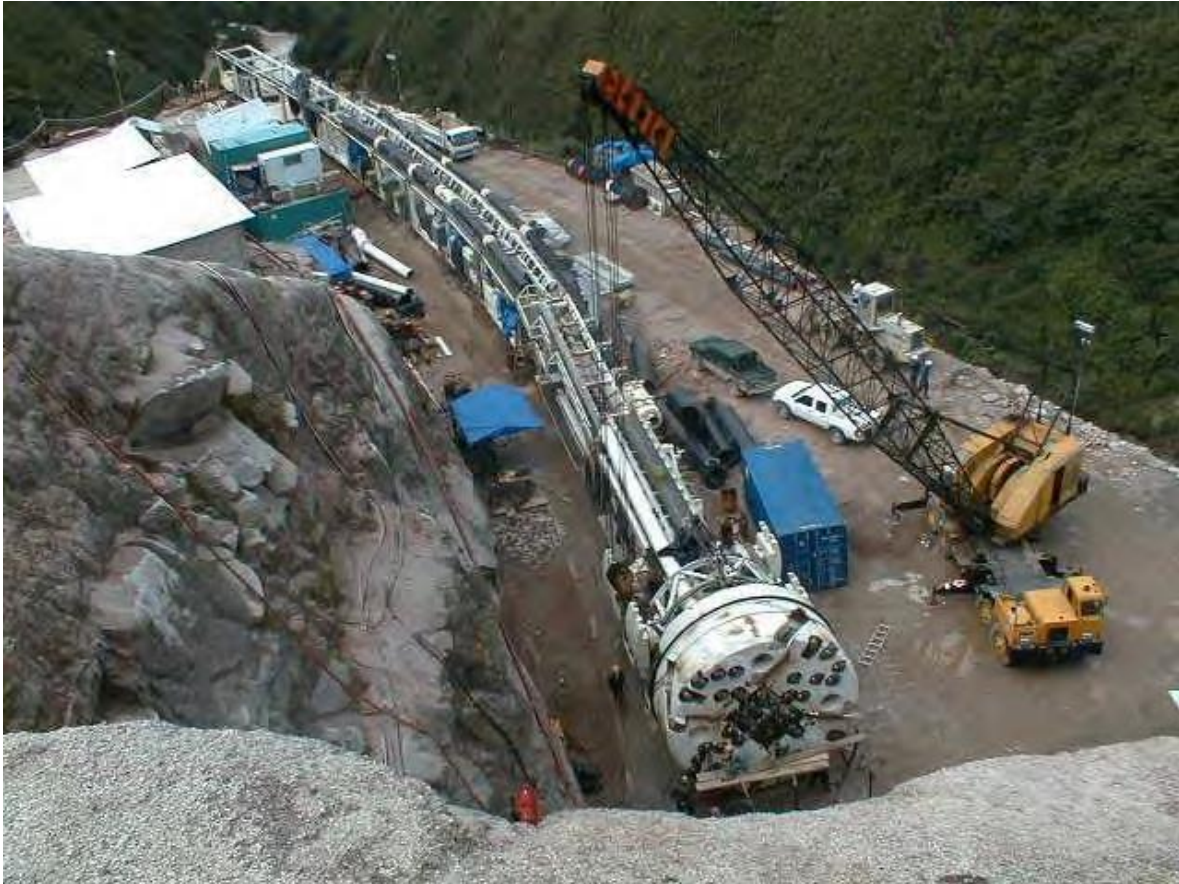
Figura (20) Vista general de un topo a punto de iniciar el ataque de la excavación
