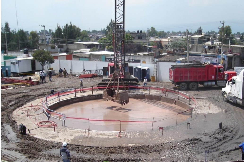
Figura (52) excavación de núcleo por medio de una almeja loca
