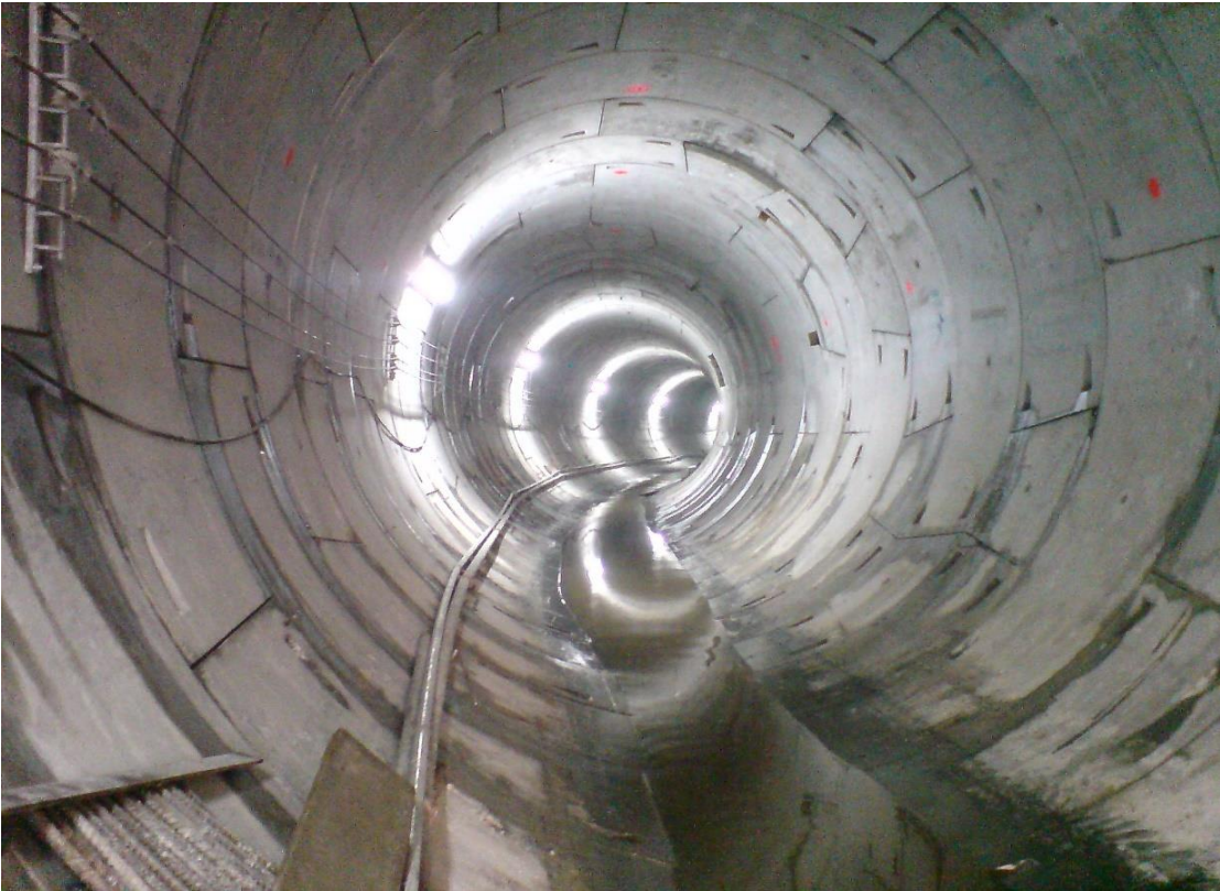
Figura (83) revestimiento primario del túnel, mediante dovelas
