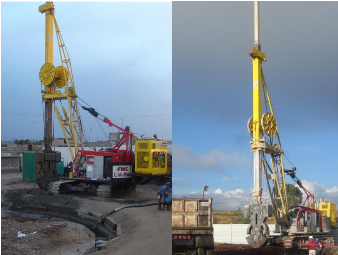
Figura (48) equipo guía montado sobre la draga para excavación en el tablero
