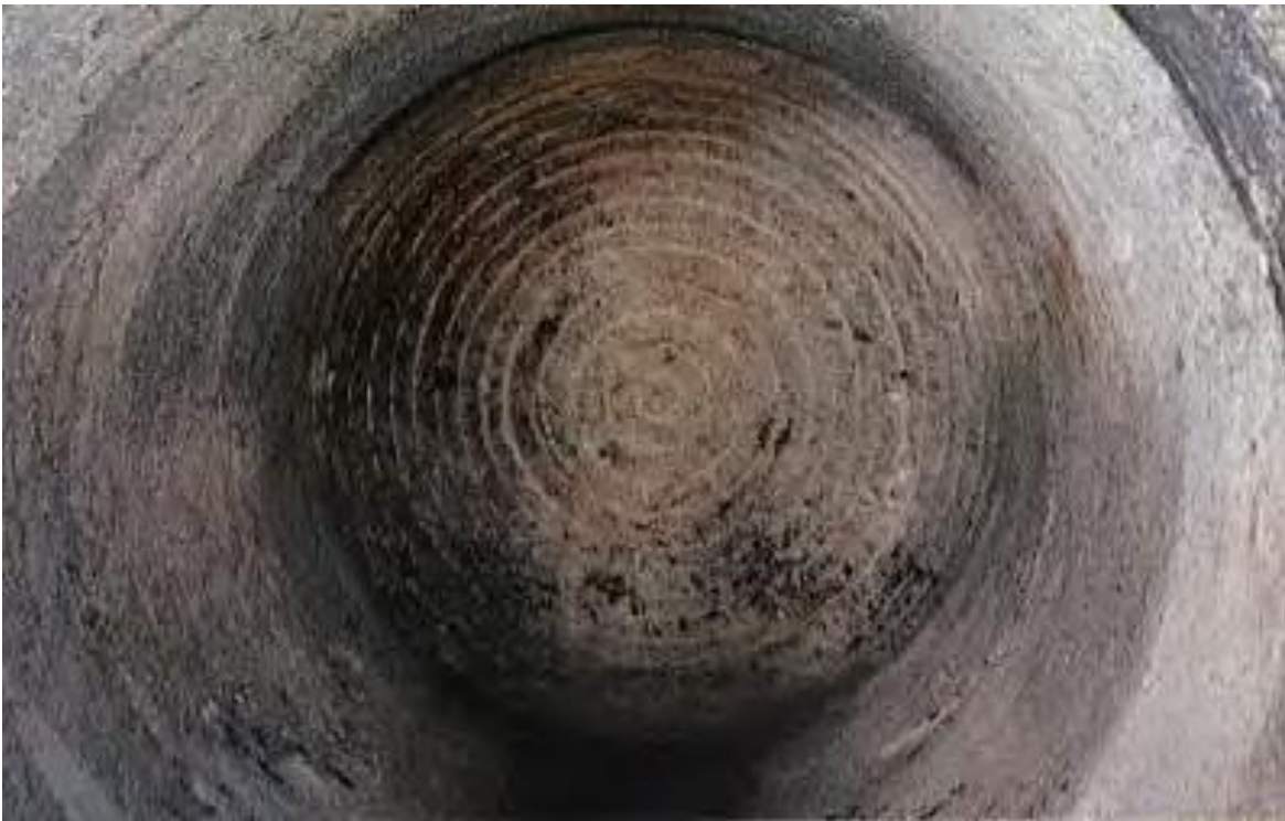
Figura (18) Círculos concéntricos dejados por los cortadores en el frente del túnel
