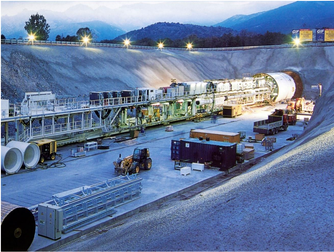
Figura (22) Vista trasera del back-up de una tuneladora
