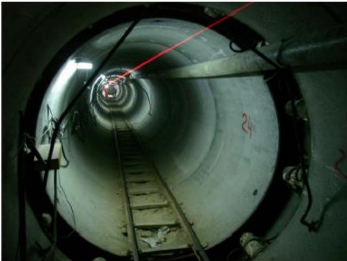
Figura (31) laser del túnel
