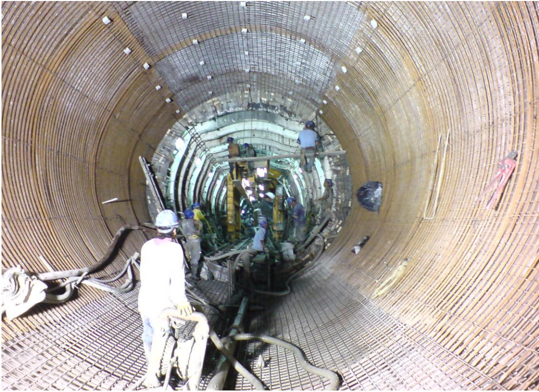
Figura (87) colocación de malla ingenieril
