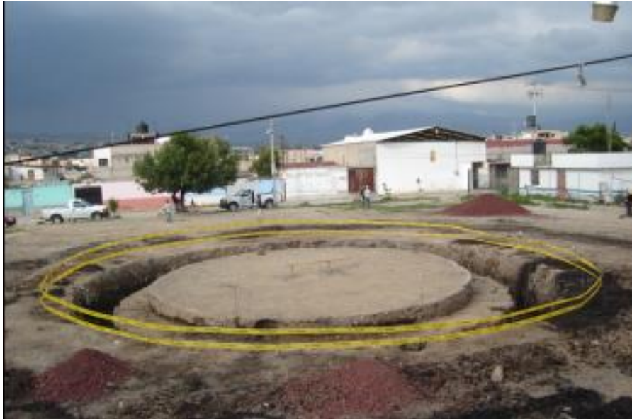
Figura (44) excavación del terreno para la construcción de los brocales provisionales
