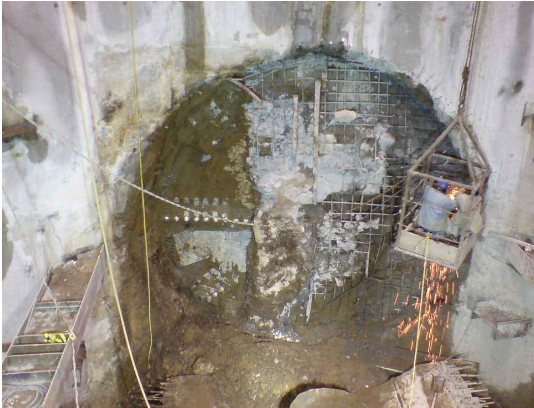
Figura (65) portal de salida del escudo
