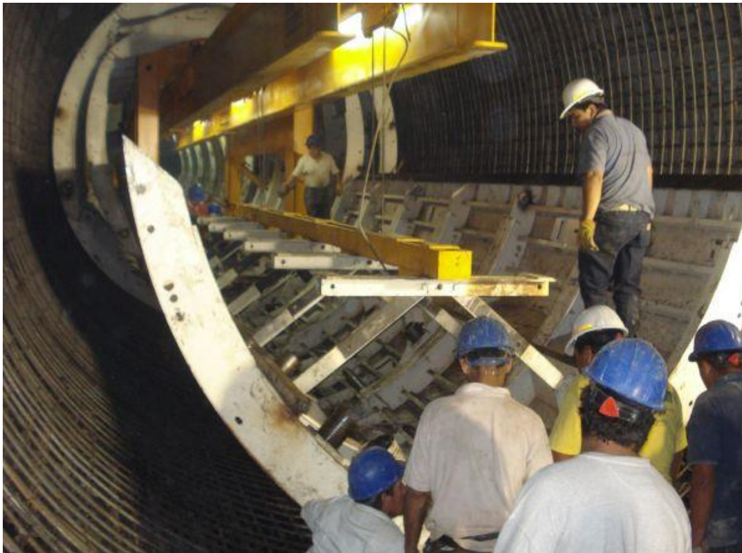
Figura (88) colocación de cimbra telescópica
