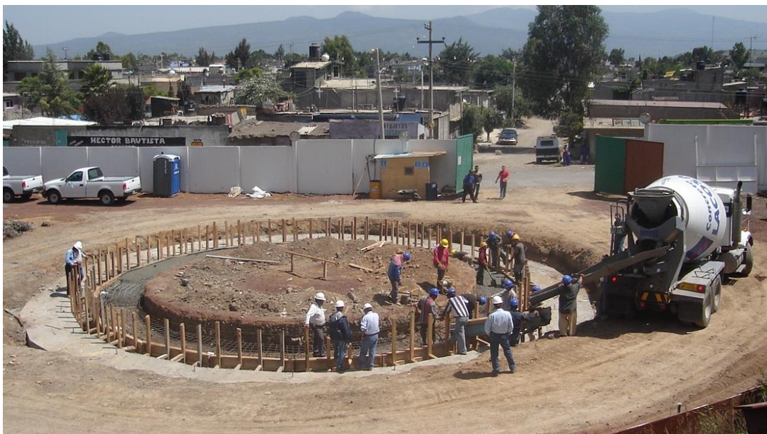
Figura (45) construcción de los brocales provisionales interior y exterior
