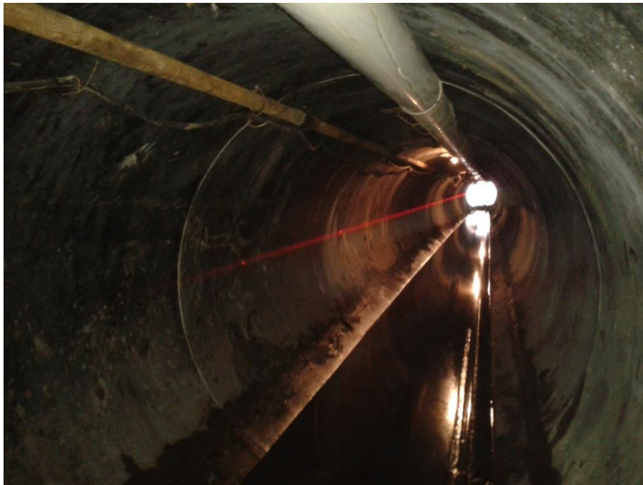
Figura (23) Verificación de la rasante y direccional con equipo de topografía convencional
