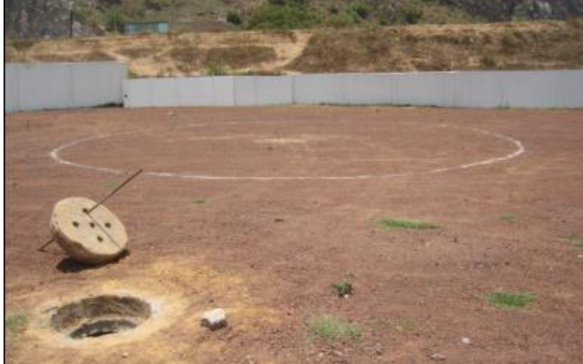
Figura (42) Adecuación del terreno para el área de trabajo
