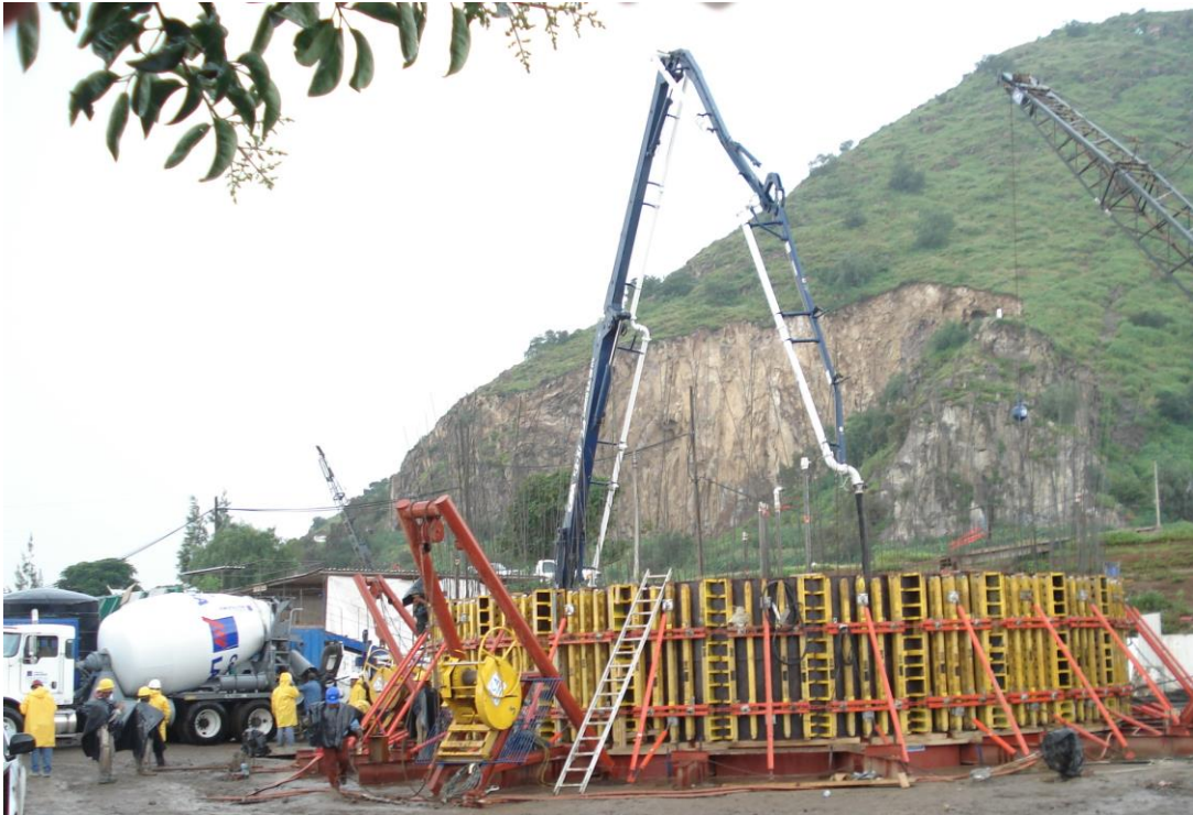
Figura (61) colado de primera sección
