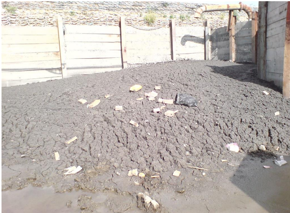
Figura (70) Tanque de descarga de lodos
