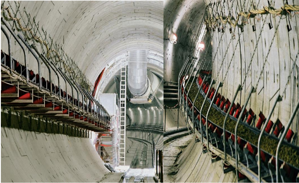
Figura (67) método de extracción de la rezaga mediante banda continua
