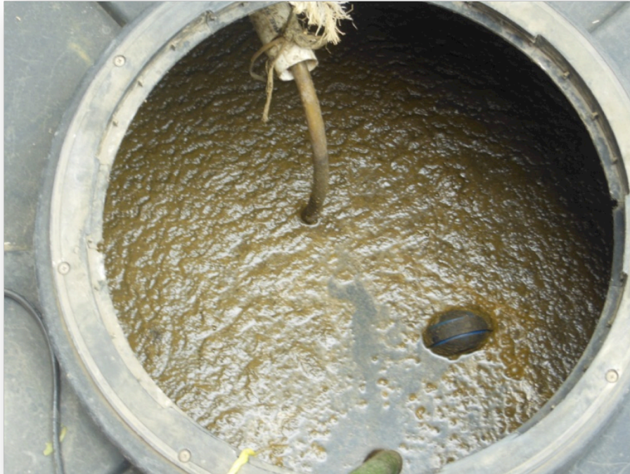
Imagen 3.3. Influyente de la toma de muestras. Fosa séptica de la (PTAR Edificio 12)
