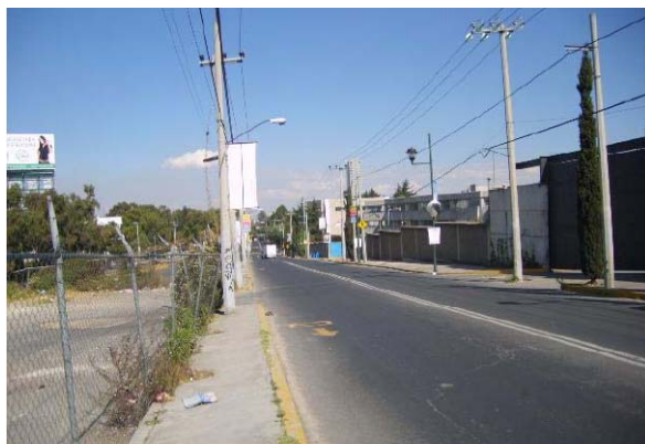
1.- Avenida Carlos Echanove Vista hacia el entronque entre las Avenidas Noche de Paz. Carretera al Olivo v Loma del Parque.
