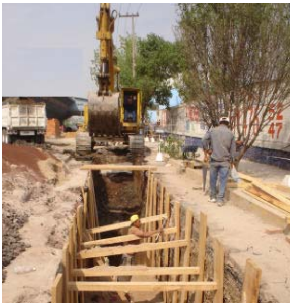
Troquelamiento de excavación
