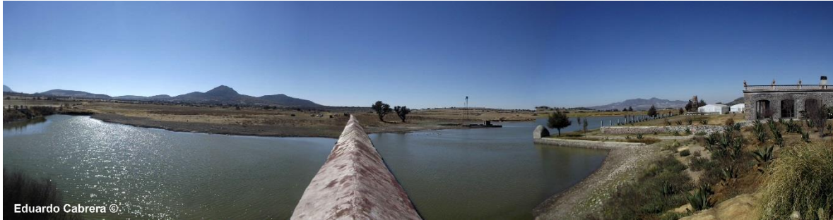
Imagen B. Vista de la represa desde el extremo aguas arriba de la arquería
