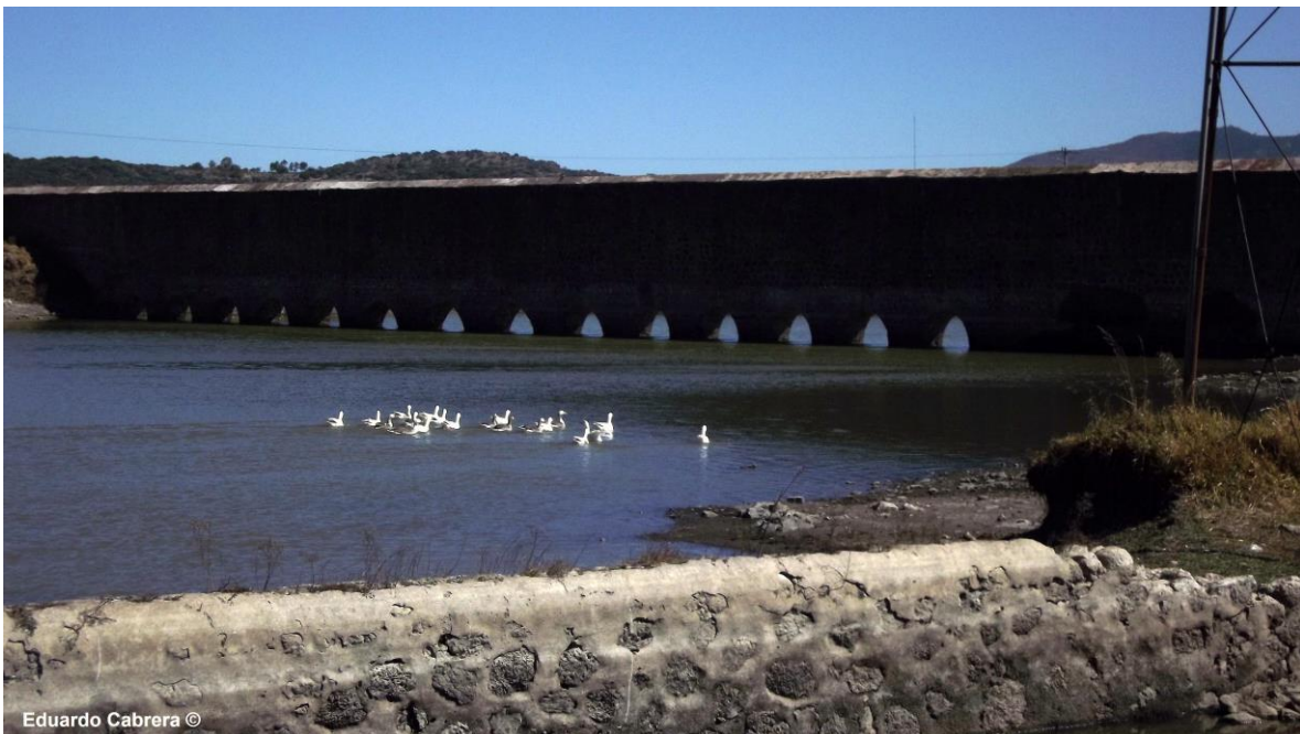
Imagen 3. 2. Arquería correspondiente al tramo analizado
