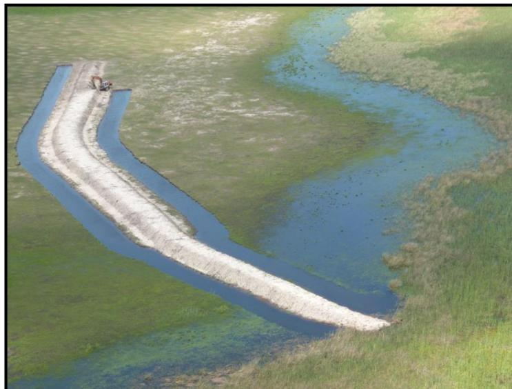
**Figura 1.8.1** Construcción de terraplén cortando el cauce natural del estero Gallo Sapukay en Argentina
