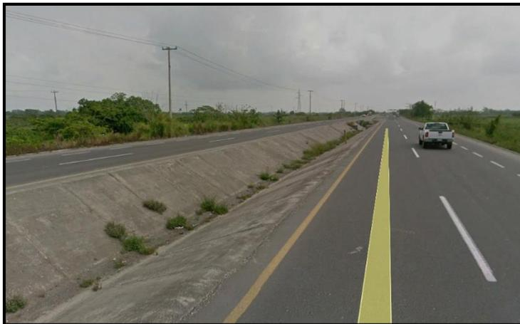
**Figura 2.3.6** Canal de drenaje pluvial entre los cuerpos A y B del km 42+160.00-44+460.00
