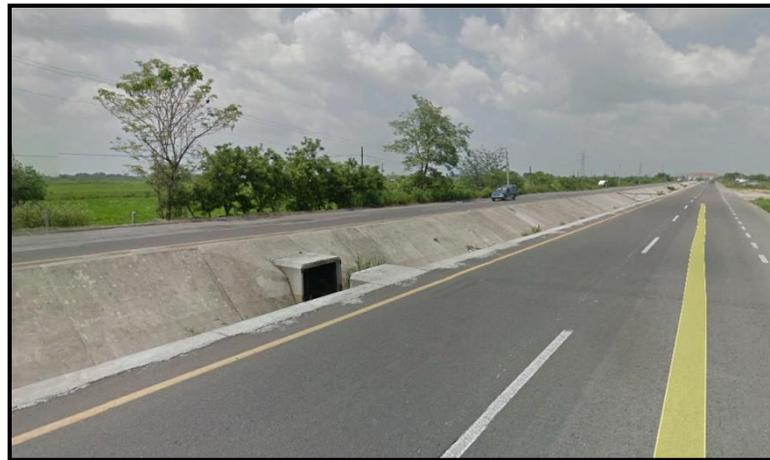
**Figura 2.3.3** Cajón de 2.00 x 2.00 m en la estación
