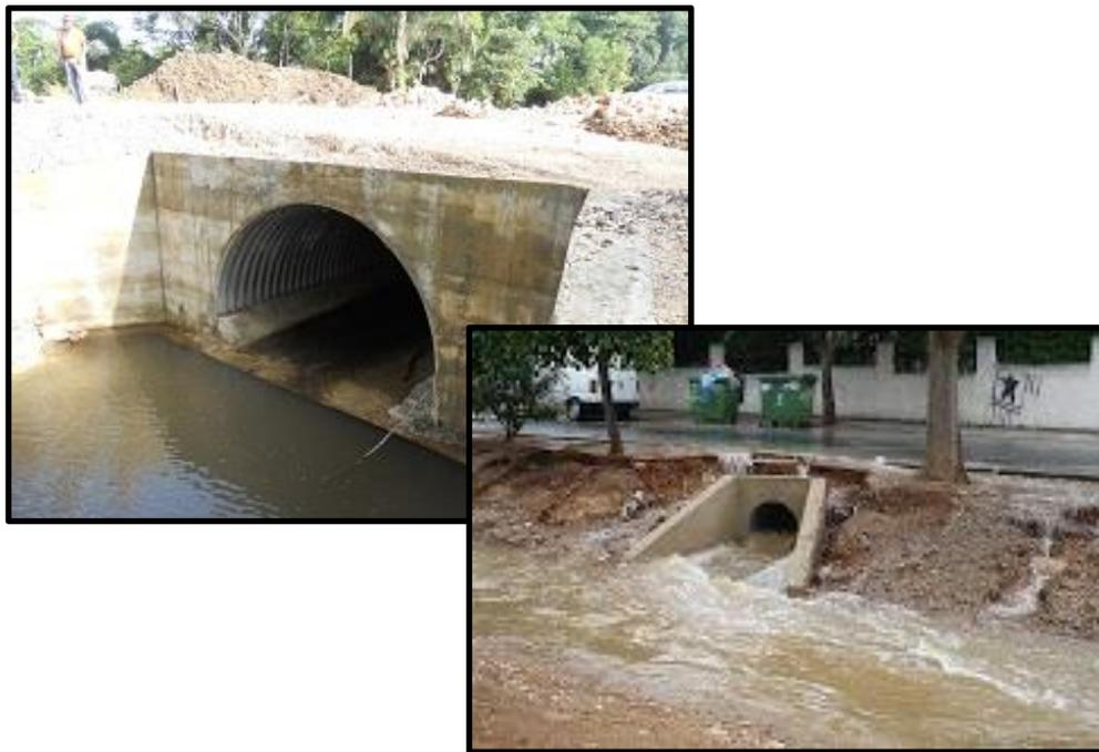
**Figura 2.2.11** Ejemplo de alcantarillas funcionando a superficie libre
