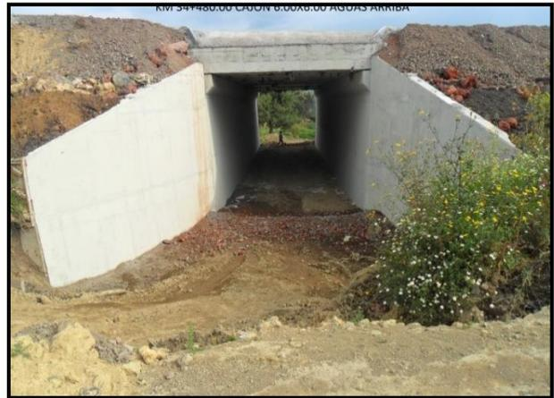
**Figura 2.2.8** Cajón de concreto de 6.00 x 6.00 m
