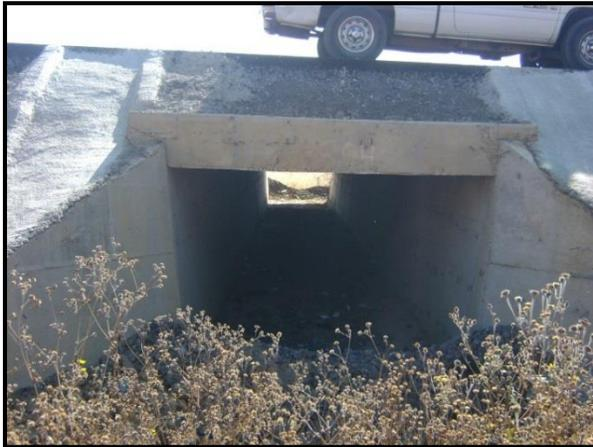
**Figura 2.2.9** Losa de drenaje
