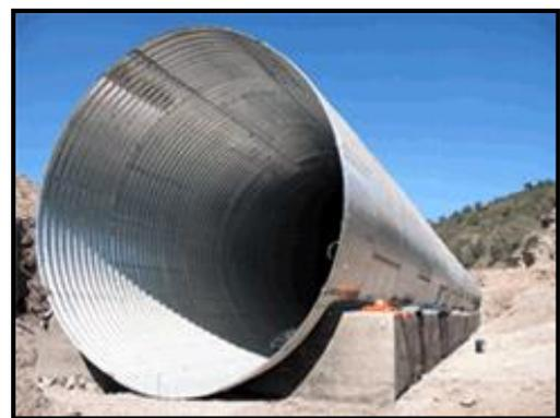
**Figura 2.2.2** Alcantarilla de Lámina
