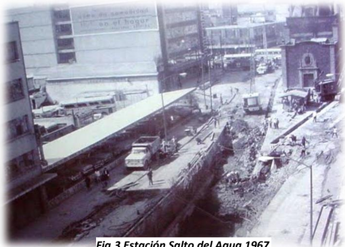
Fig.3 Estación Salto del Agua 1967
