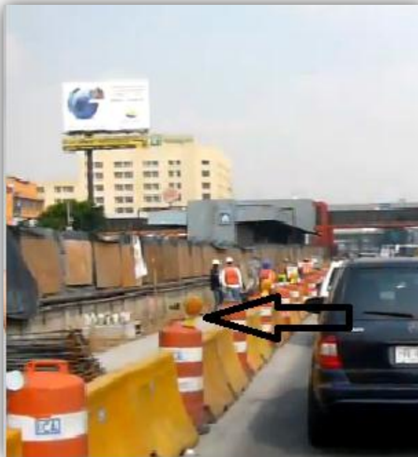
Fig. 24 Demolición de jardinera.
