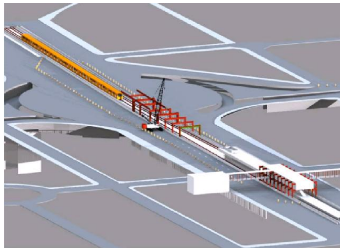
Fig. 55 Montaje de travesas longitudinales.
