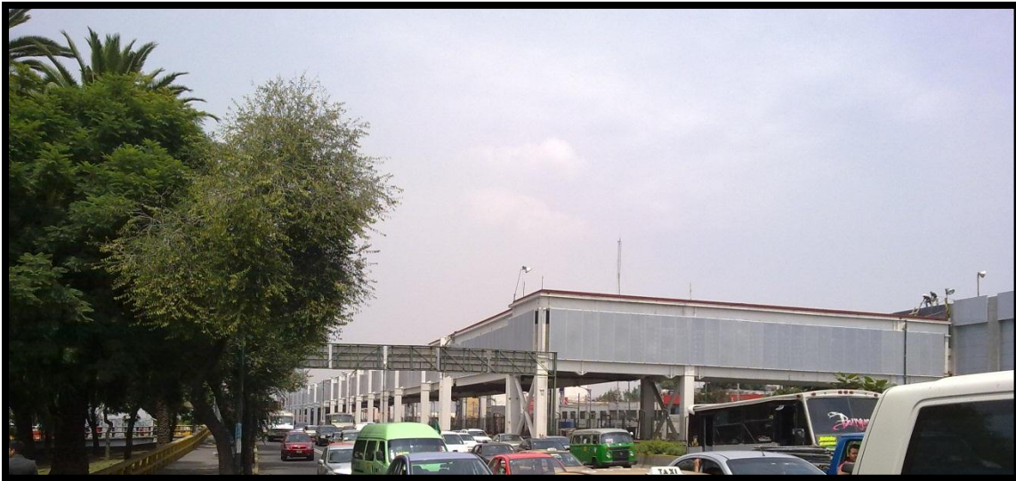
5 Perspectiva general de la pasarela.
