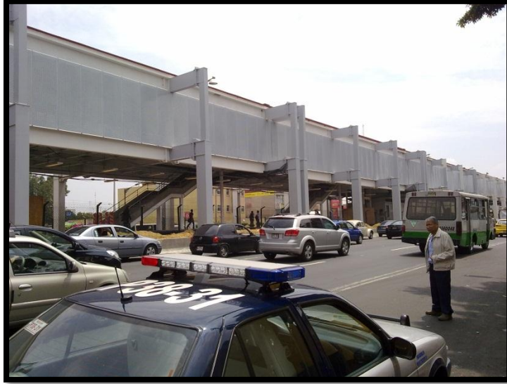
2 Rehabilitación de la Av. Tlalpan.
