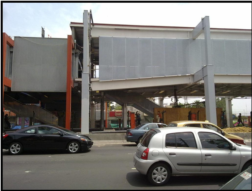
1 Estructura metálica módulo 7, unión con Línea 2.
