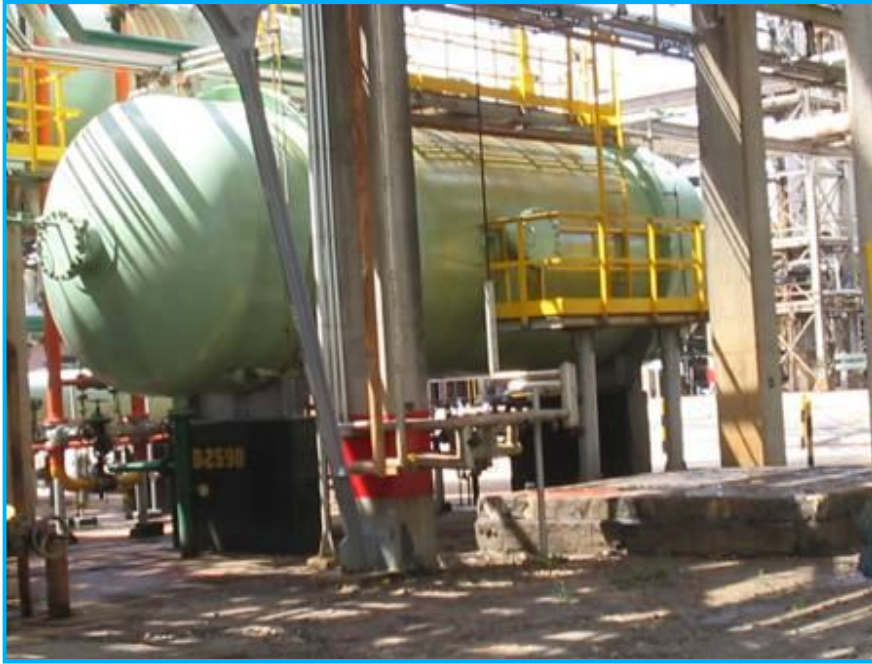
Figura 1-41) Esquema de un separador horizontal.
