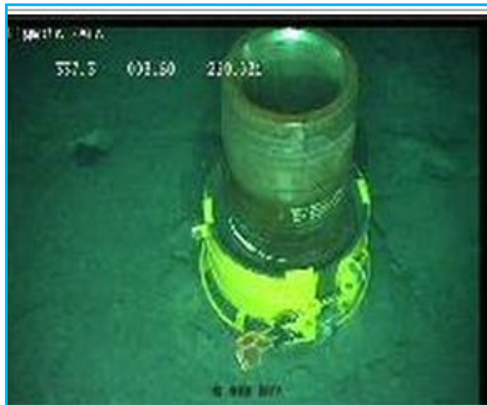
Figura 2-16) Cabezal submarino instalado en un pozo del Mar del Norte.
