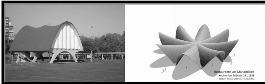
Ilustración 2.19. Estructuras tipo cascarón.
