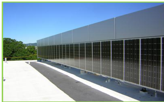
Figura 6-7 Ventanas con celdas fotovoltaicas integradas. Universidad de Oregon, Centro de ingeniería Kelley. Fuente: David Summers, PE, LEED®AP, Los Angeles.
