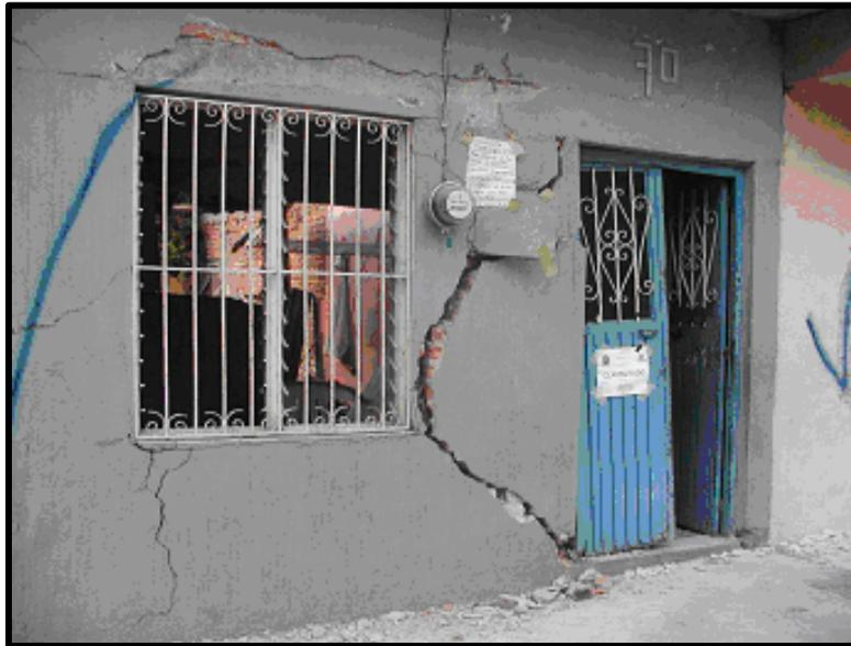
Figura 4.20.- Agrietamiento de muros en vivienda debido a un sismo, CENAPRED.
