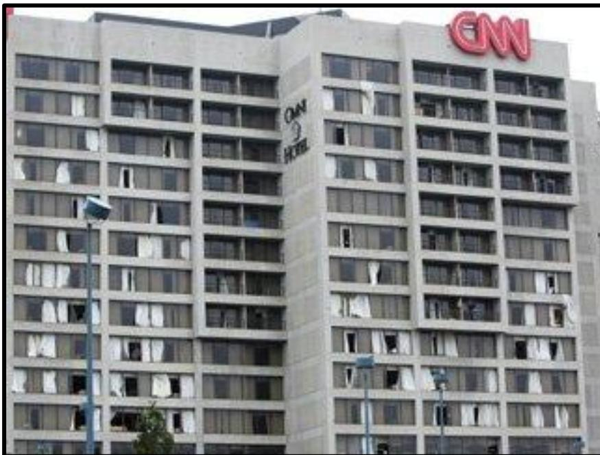
**Figura 4.12.-** Ventanas rotas en el edificio de CNN por fuertes vientos. Atlanta EE.UU.
