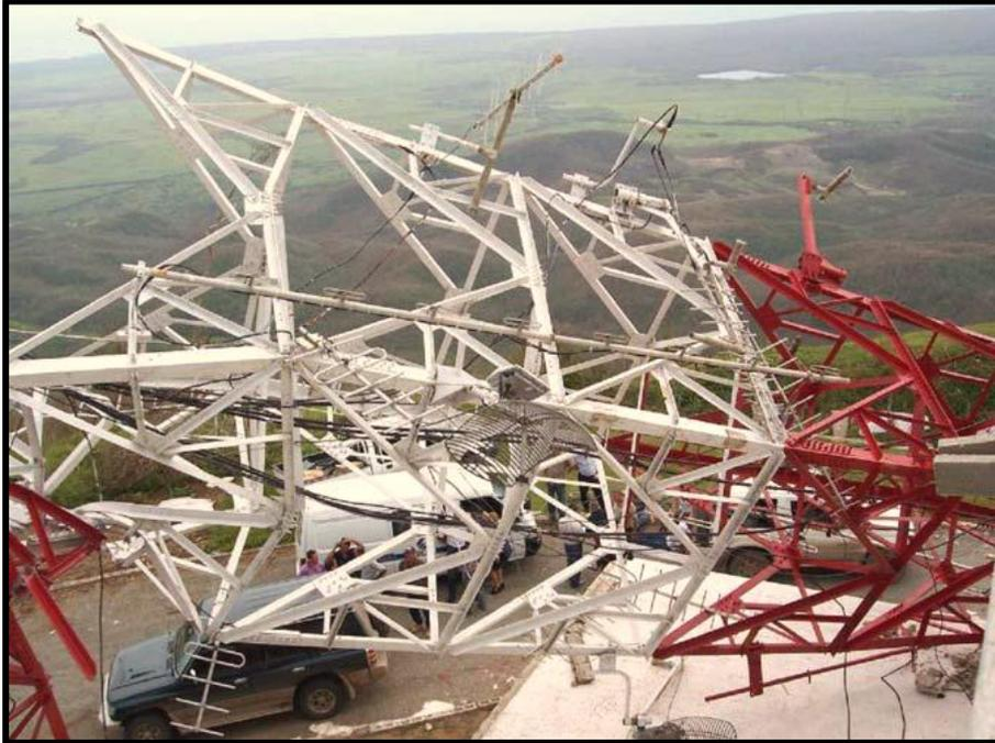
**Figura 4.15.-** Colapso de torre reticulada para comunicaciones ante el paso de un huracán, Cuba.
