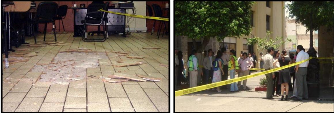
**Figura 4.24.-** Registro de agrietamiento en el primer piso de un edificio causado por las vibraciones producidas por el tráfico vehicular, provoco la evacuación de los trabajadores, Guadalajara Jalisco.
