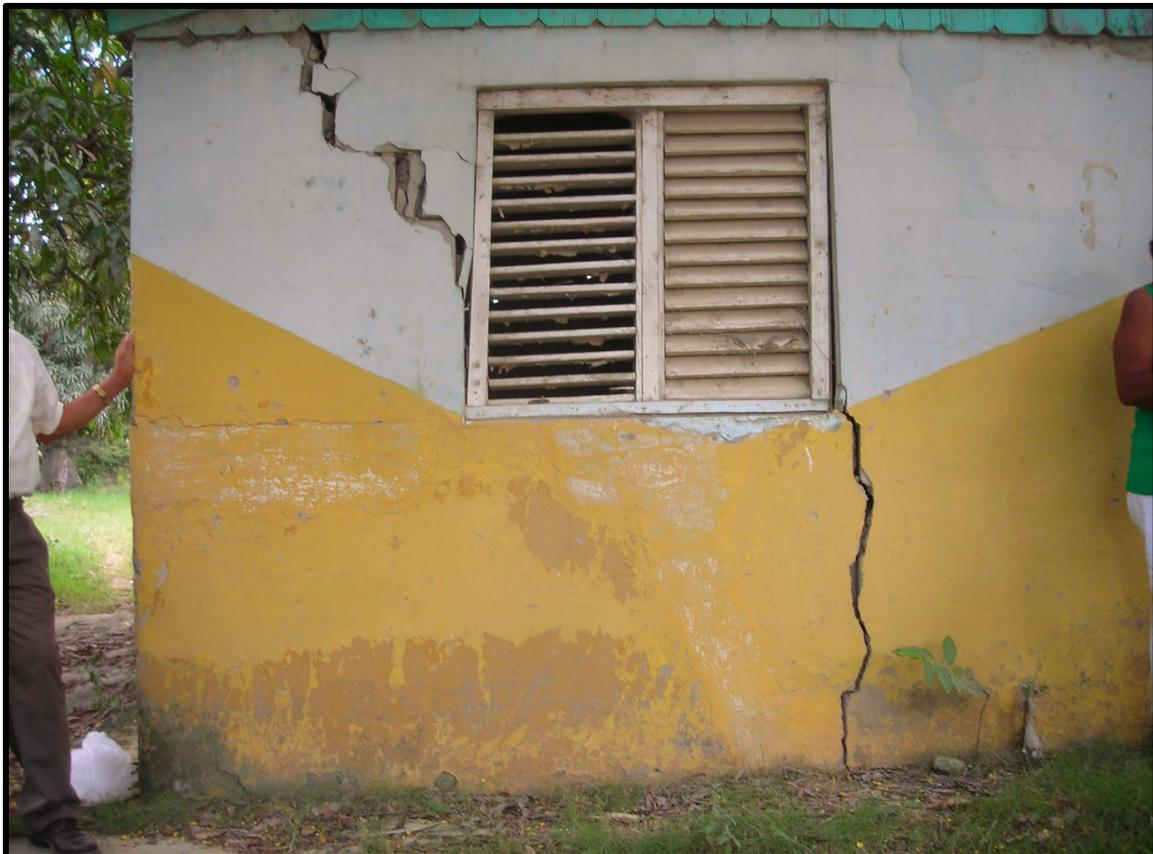
**Figura 4.10.-** Grieta producida por las vibraciones causadas por las maquinarias de una fábrica cementera localizada a pocos metros del lugar. República Dominicana.
