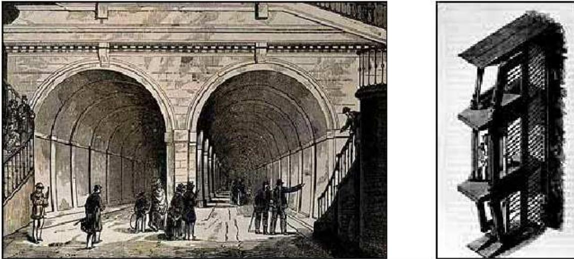
Figura No. 5 Ala izquierda una imagen de época del túnel construido bajo las aguas del río Támesis y a la derecha otra del escudo utilizado y patentado por Brunel para este mismo proyecto (1843).
