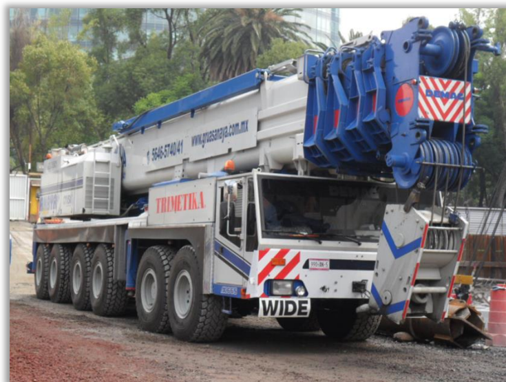
Figura 26. Grúa para montar las traves Fuente: Elaboración propia
