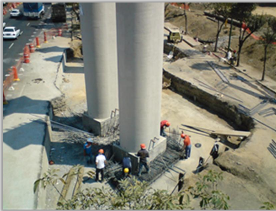
Figura 9. Zapata con columnas prefabricadas y trabajos de descimbrar Fuente: Elaboración propia
