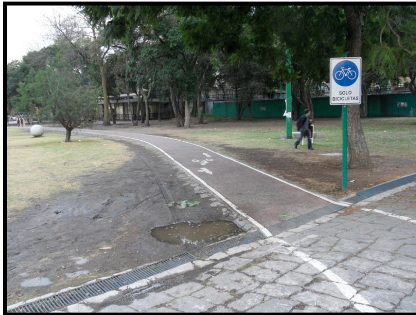
Fotografía 19: Señalamiento de Infraestructura ciclista segregada (elaboración propia).
