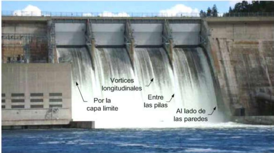
Fig. 3.12 Formas de arrastre de aire en un vertedor- Canyon Ferry Montana (Foto obtenida de la página web de montanafilm).
