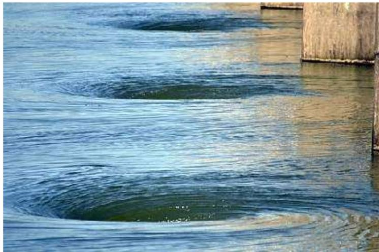
Fig. 2.10 Formación de vórtices por la apertura de las compuertas del vertedor de la central hidroeléctrica Yacyreta. (Ramírez, 2011)
