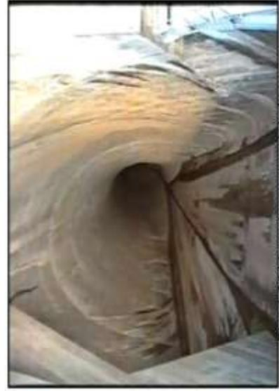
Fig. 1.30 Vertedor en túnel de la presa Aldeadávila en España (Foto obtenida de Wikipedia).
