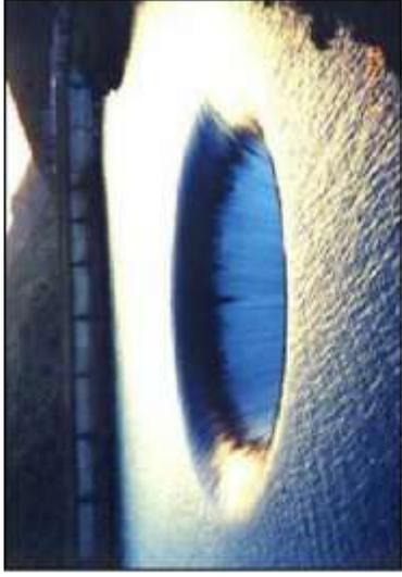
Fig. 1.27 Vertedor de embudo de la presa Glory Hole en California (Foto obtenida de la página web de "Ingeniería en la red").
