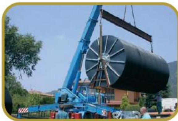
Ilustración 48. Contactor Biológico Rotativo
