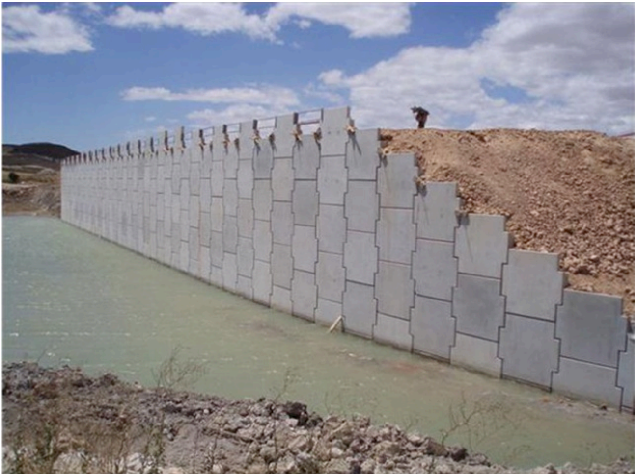
Fotografía 2.2 Sistema de Tierra Armada.
