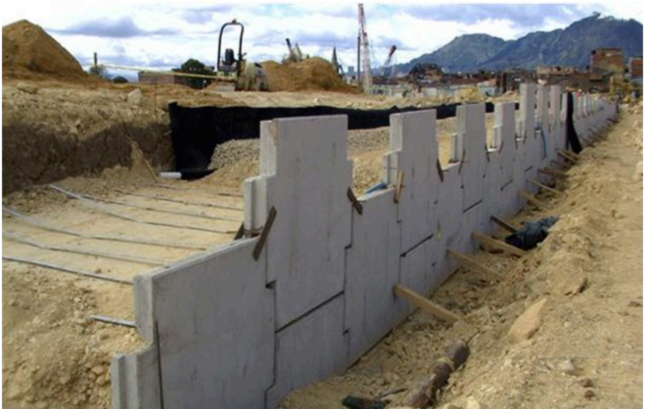
Fotografía 2.3 Refuerzo con tiras metálicas para el sistema de Tierra Armada.
