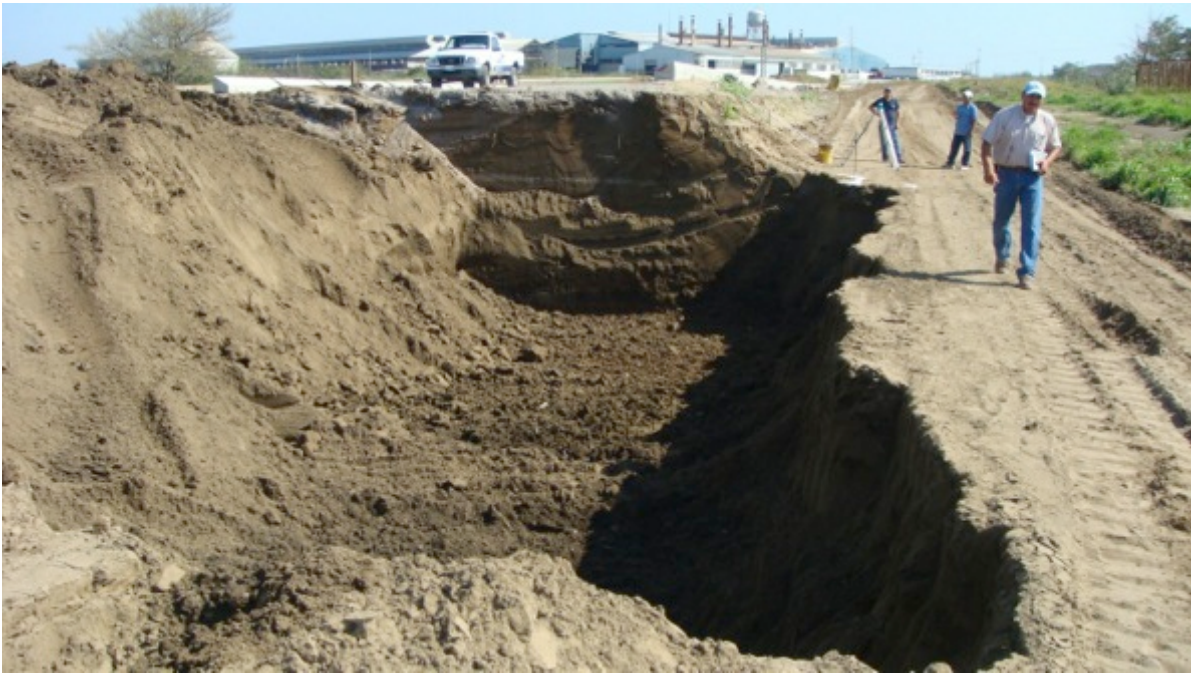
Fotografía A.4.3 Trabajos de topografía que se realizaron durante la obra.
