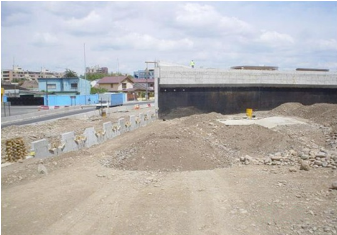
Fotografía 3.2 Terraplenado del material de relleno.
