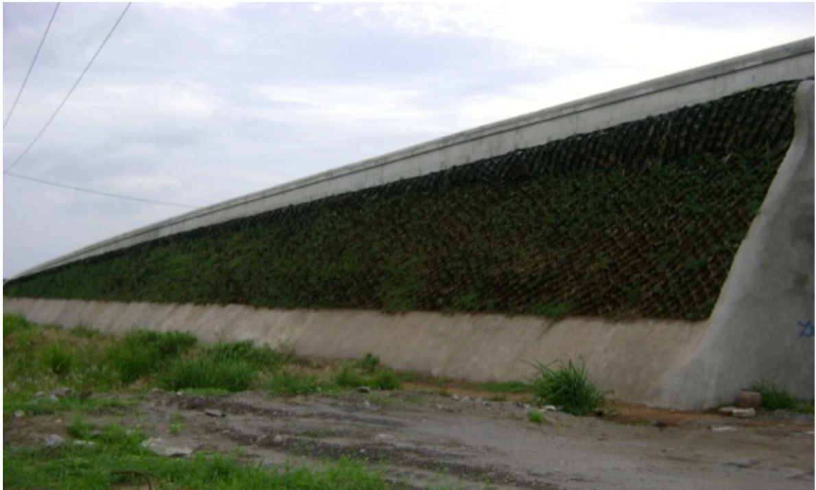
Fotografía A.4.7 Colocación de geocelda, se sujeta en la zanja de anclaje con varilla de ¼" (grapas).
