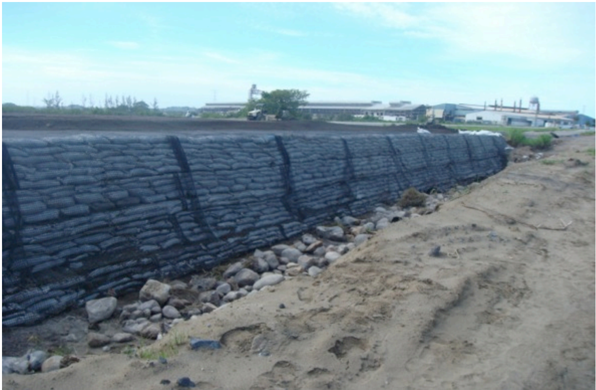
Fotografía A.4.6 Altura y cimbra del talud.
