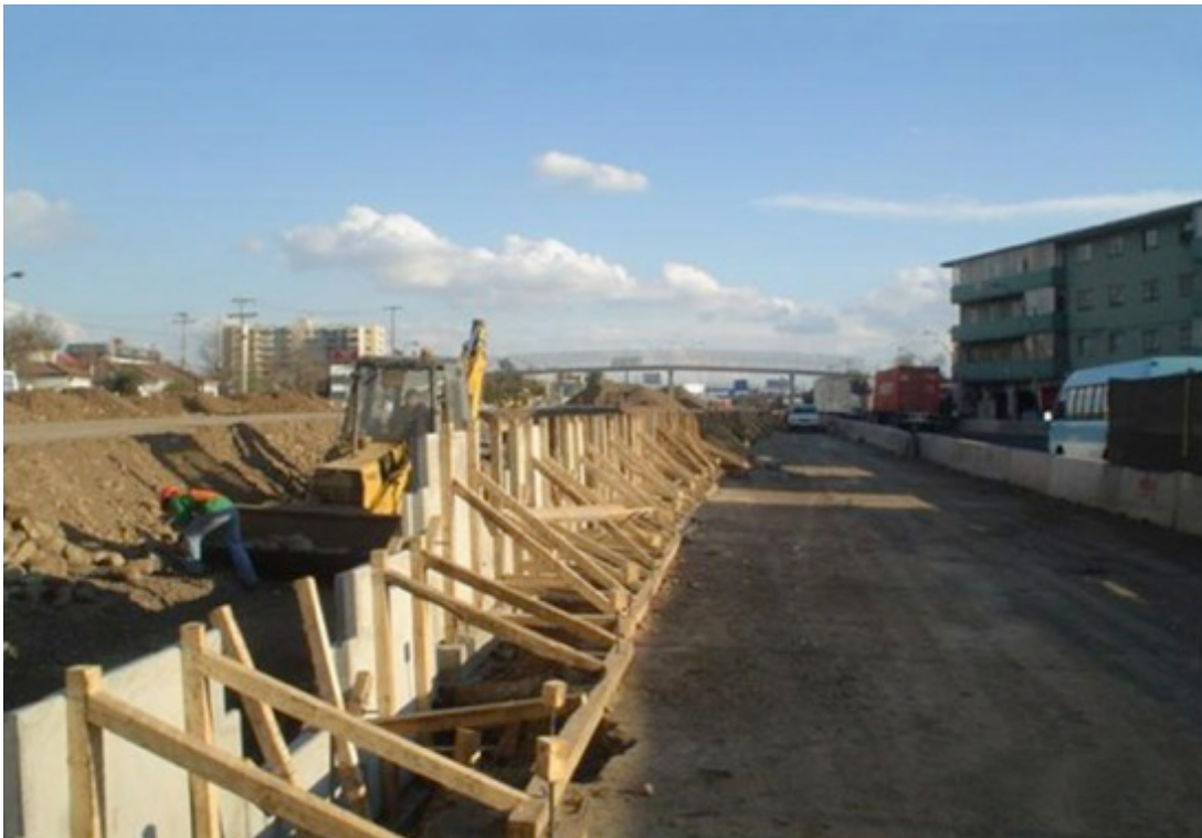
Fotografía 3.4 Montaje de la primera fila de escamas.
