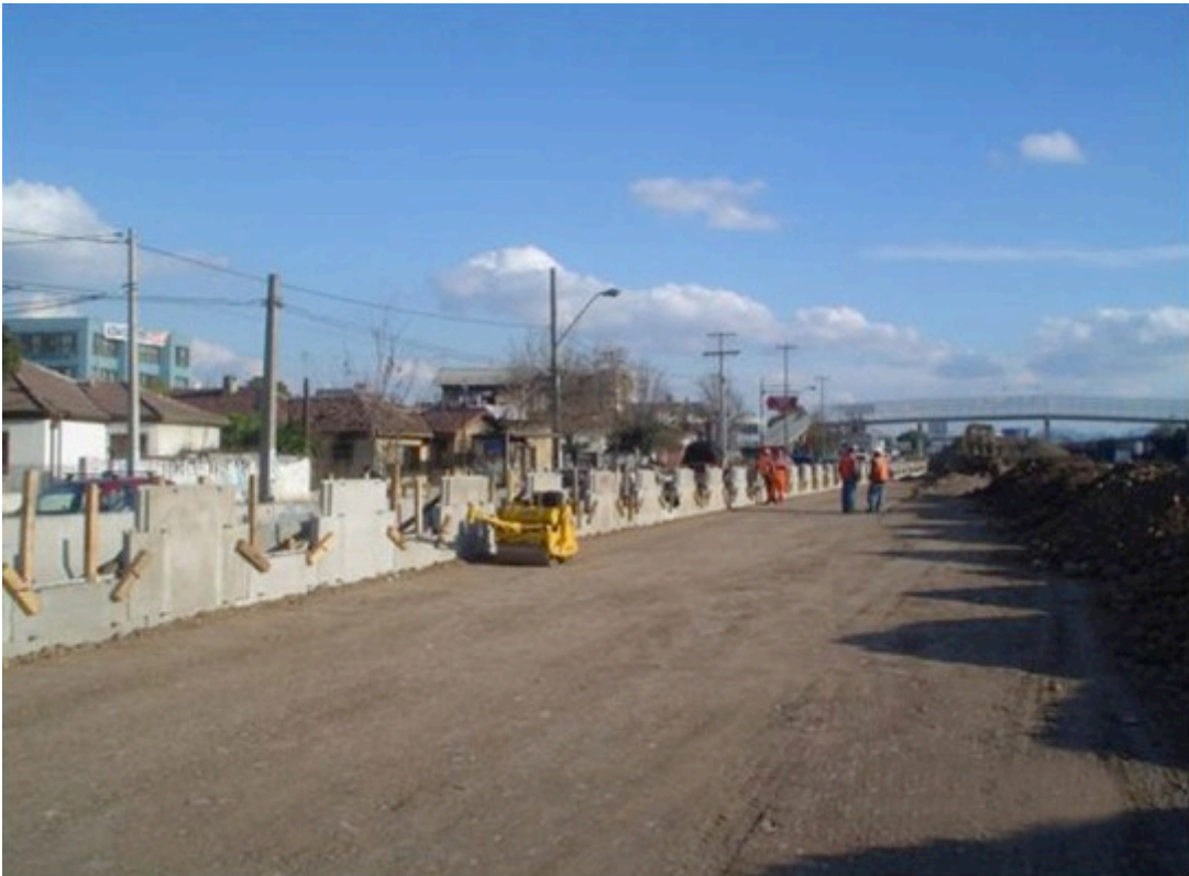
Fotografía 3.3 Compactación del terraplén con equipo ligero en el metro y medio más próximo al paramento.
