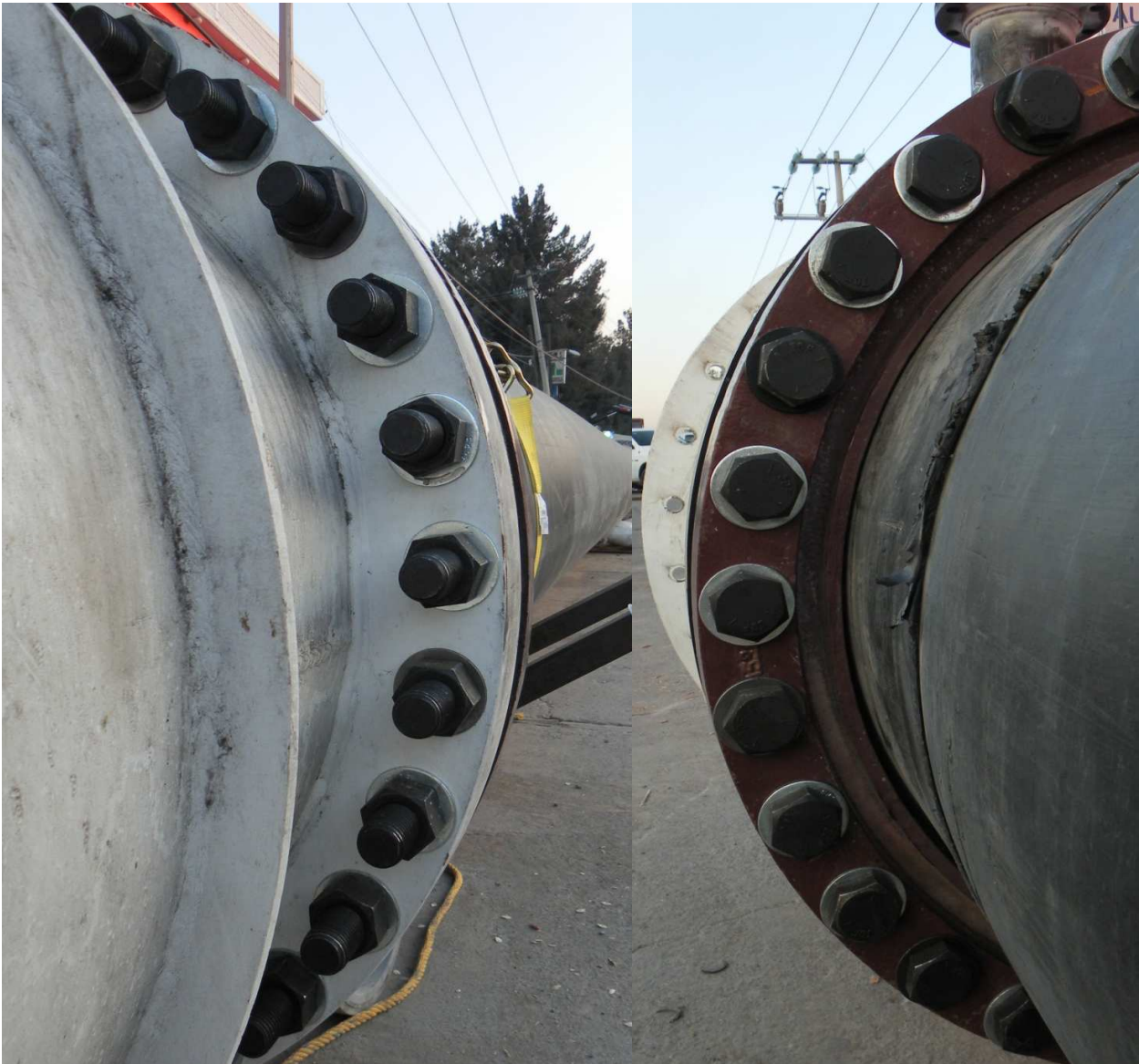
Fotografía 4. Tuberías PEAD unidas.
