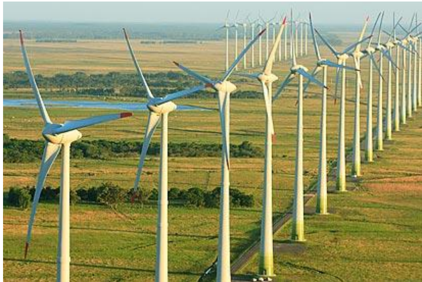
FIG. 1- SERIE DE AEROGENERADORES EN UN PARQUE EOLICO,
