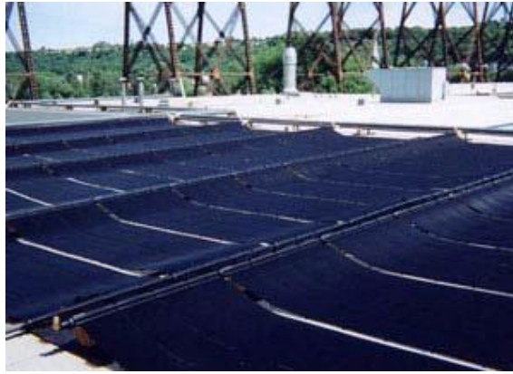
FIG. 19- COLECTORES SIN CUBIERTA
