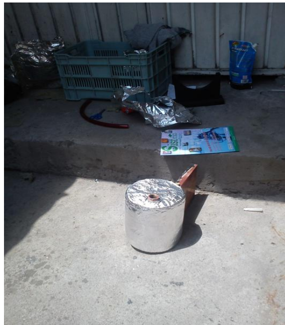
IMG. 12-AISLAMIENTO DEL TANQUE
