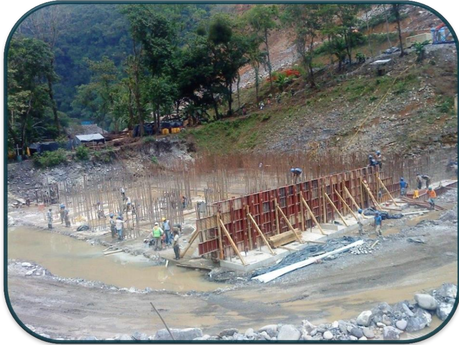
FOTOGRAFIA No.45.-En este elemento se vio que ningún equipo de trabajo tenía espacio libre para trabajar sino en conjunto de los demás frentes.
