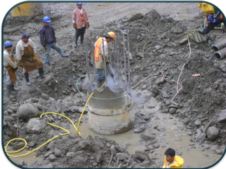
FOTOGRAFIA No.34.-Se realizaba 18 hrs después de su colado ya que este se pone tan duro que entre más tiempo se deja pasar más difícil es el descabece.
