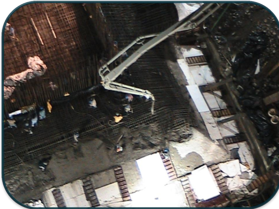
FOTOGRAFIA No.84.-Cuando en concreto llego a dar el recubrimiento en la parte baja de la zapata se comenzó a colocar una capa de curacreto y a ponerle la membrana que permitió mantener su temperatura.
