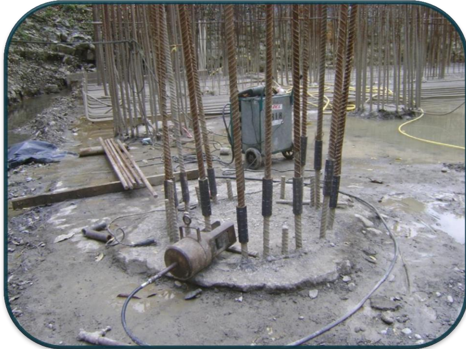
FOTOGRAFIA No.49.-A los pilotes se les acoplaron varillas por medio de un cople de compresión.
