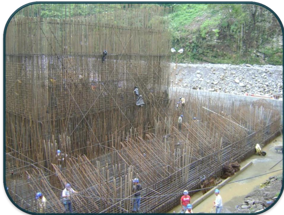
FOTOGRAFIA No.64.-Aunque algunas veces en la estética no ayuda las anclas de acero que se necesitaban para mantener la estructura en su lugar.
