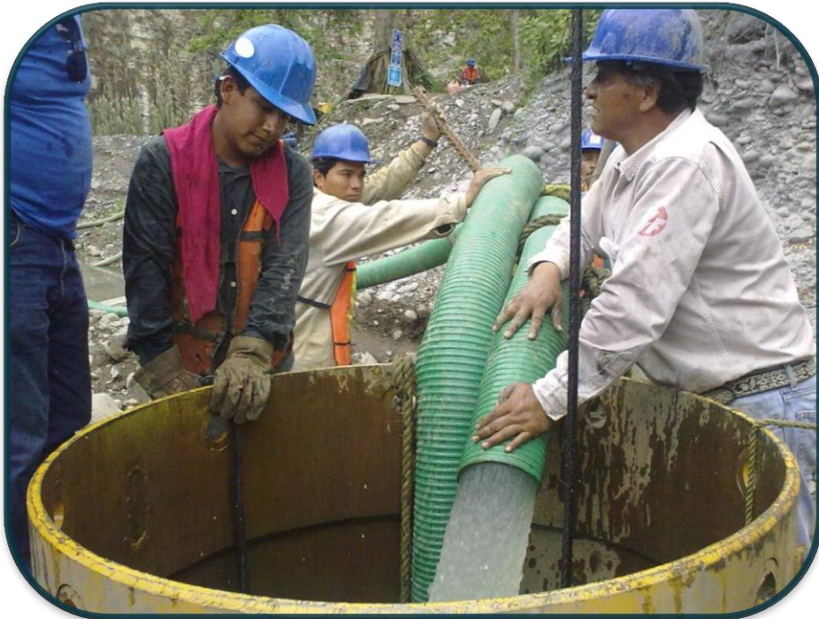
FOTOGRAFIA No.12.-Ya terminados los trabajos de perforación se realiza limpieza de los pilotes introduciéndoles agua y bombeando el lodo que se genere por medio de compresoras, mangueras y bombas de lodos.
