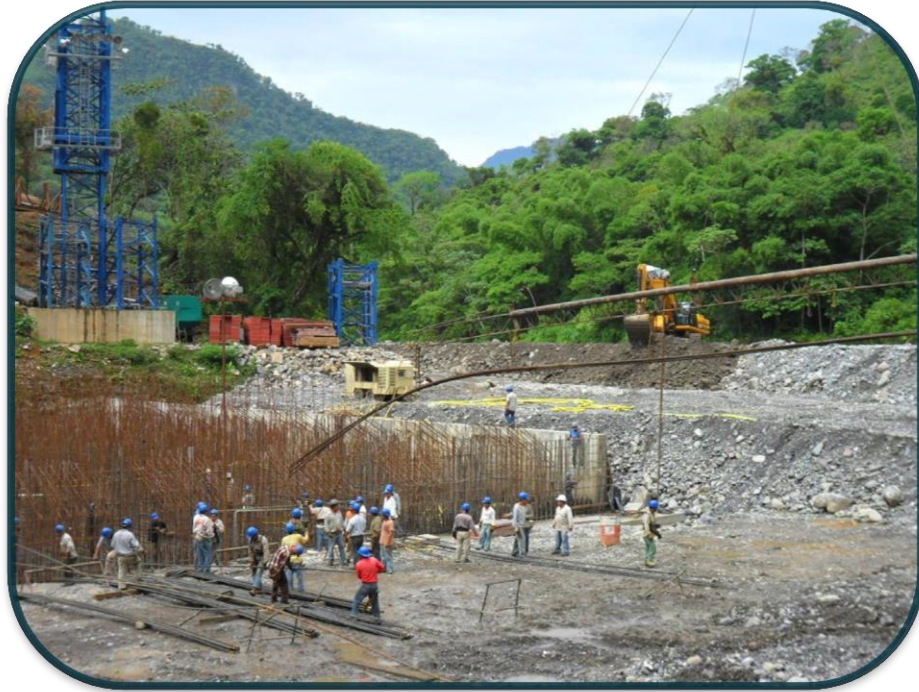
FOTOGRAFIA No.69.-Llegaba el acero por medio de la grúa y a mano colocaban varilla por varilla.
