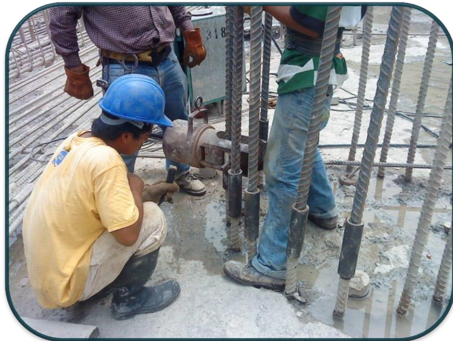
FOTOGRAFIA No.50.-En este proyecto se utilizaron coples de rosca y de compresión para este caso por su comodidad se utilizo el de compresión por medio hidráulico.
