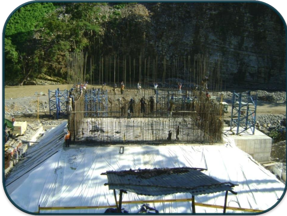
FOTOGRAFIA No.87.- Ya terminado el proceso de colado de la zapata, se monitoreo la temperatura del fraguado para verificar que no rebasara el gradiente durante una semana y se continuo el armado de acero del fuste.
