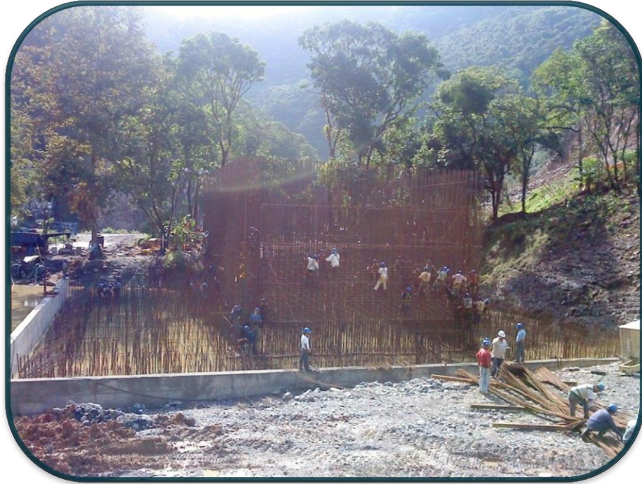
FOTOGRAFIA No.61.- Algunas veces el exceso de lluvia provoco que esta se inundara pero los equipos de bombeo desalojaban el agua en unas horas.
