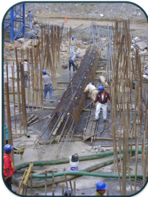
FOTOGRAFIA No.22.-A todos los pilotes se le colocaron los tubos para sus estudios posteriores y unos separadores en forma de donas para que permitiera el deslizamiento del pilote en su colocación.
