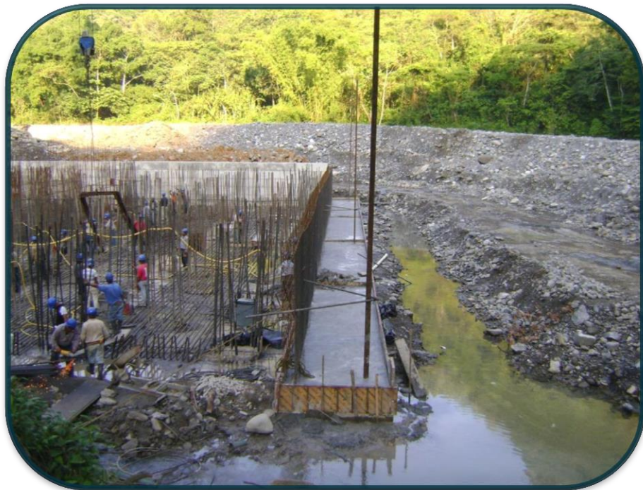
FOTOGRAFIA No.42.-Se colaban los apoyos y luego el muro perimetral.
