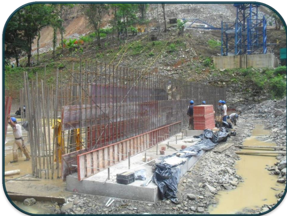
FOTOGRAFIA No.46.-Los módulos del muro perimetral se diseñaron de tal forma que su fabricación fue rápida y sencilla.
