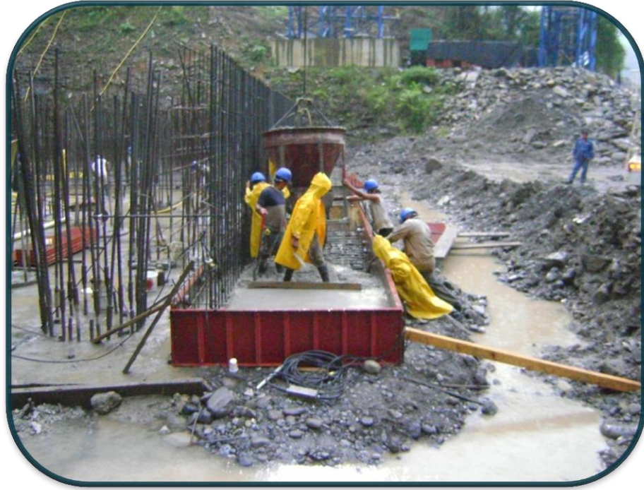
FOTOGRAFIA No.47.-Algunos de los colados se realizaron a pesar de las lluvias que se presentaron.
