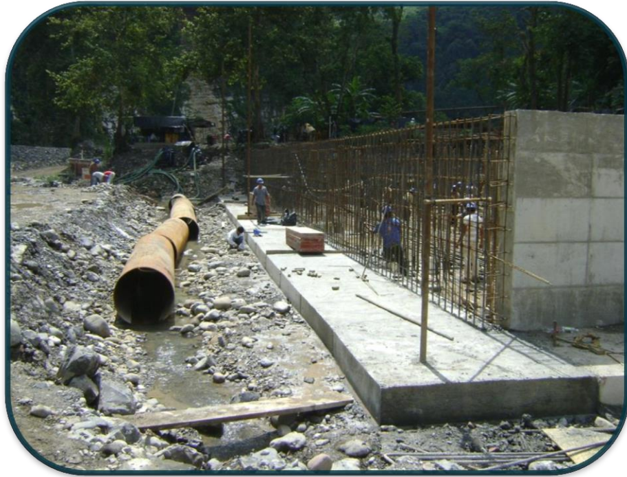
FOTOGRAFIA No.41.-El muro que tubo función de cimbra de la zapata y evitar contaminación en caso de inundación se realizo en varias etapas.
