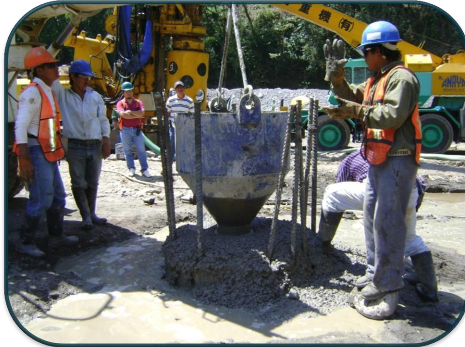
FOTOGRAFIA No.31.-Hasta que el resultado es el concreto limpio y de buena calidad.
