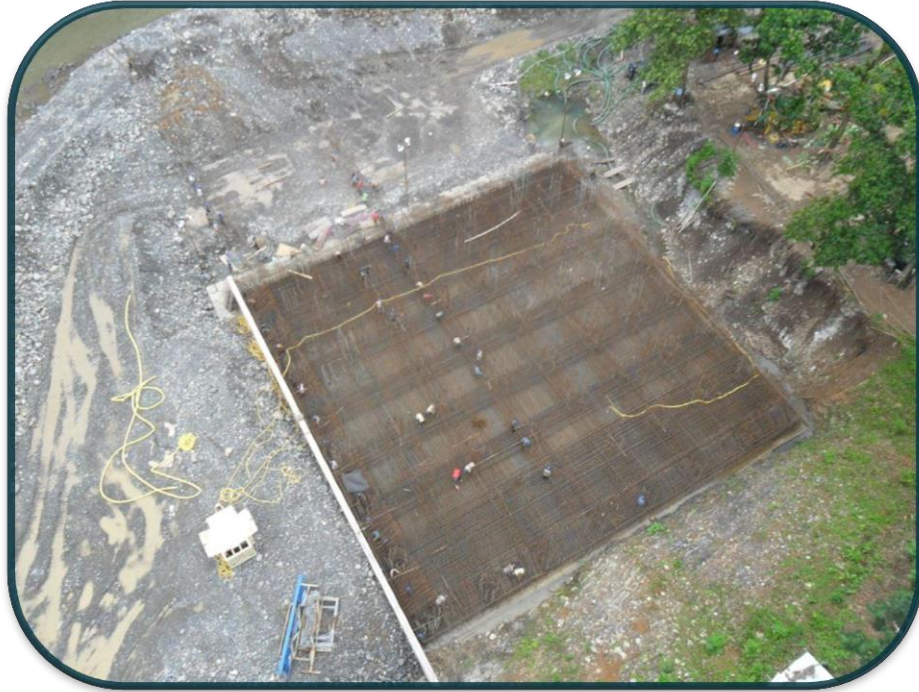
FOTOGRAFIA No.75.-En el diseño perimetral se considero que primero tendría que colocar la capas inferiores de acero para así poder cerrar los muros y que este no estorbara en el momento de colocacion de acero.
