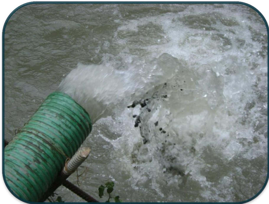
FOTOGRAFIA No.16.-Hasta que sale de nuevo el agua limpia se considera que esta libre de impurezas.
