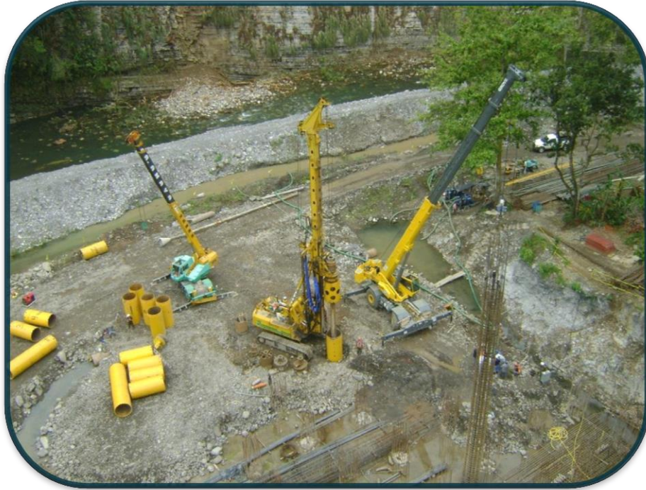
FOTOGRAFIA No.3.-Después de la primera etapa se realizo la perforación de los pilotes que adhieren a la zapata con el suelo.
