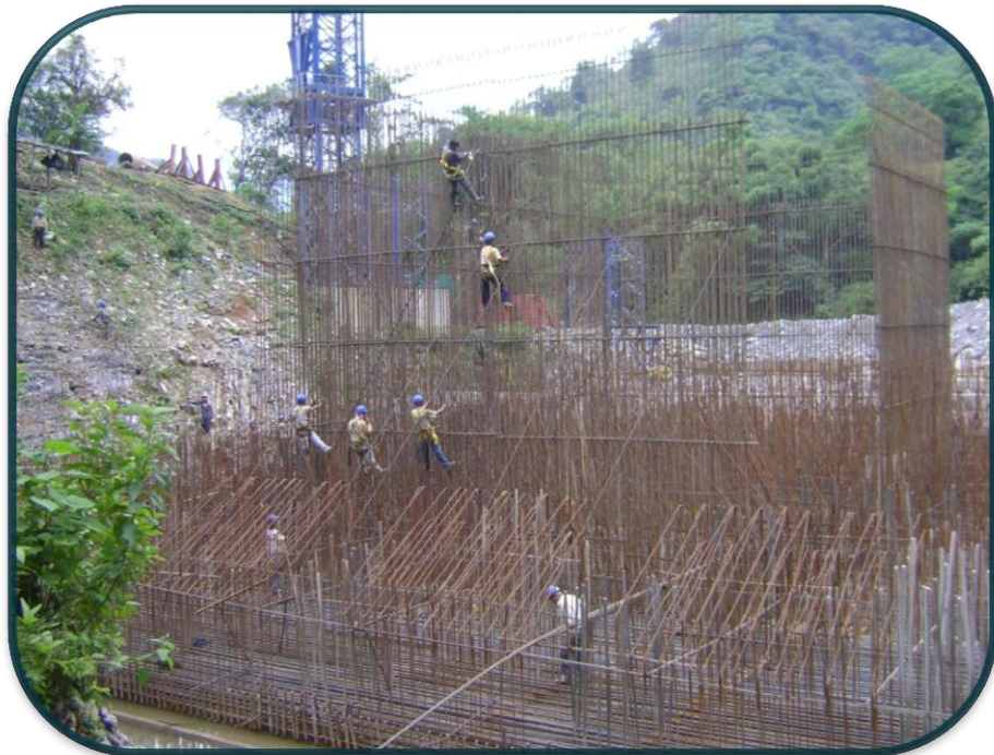
FOTOGRAFIA No.66.-La forma de la estructura se mostro al colocar los fustes de la columna 4.
