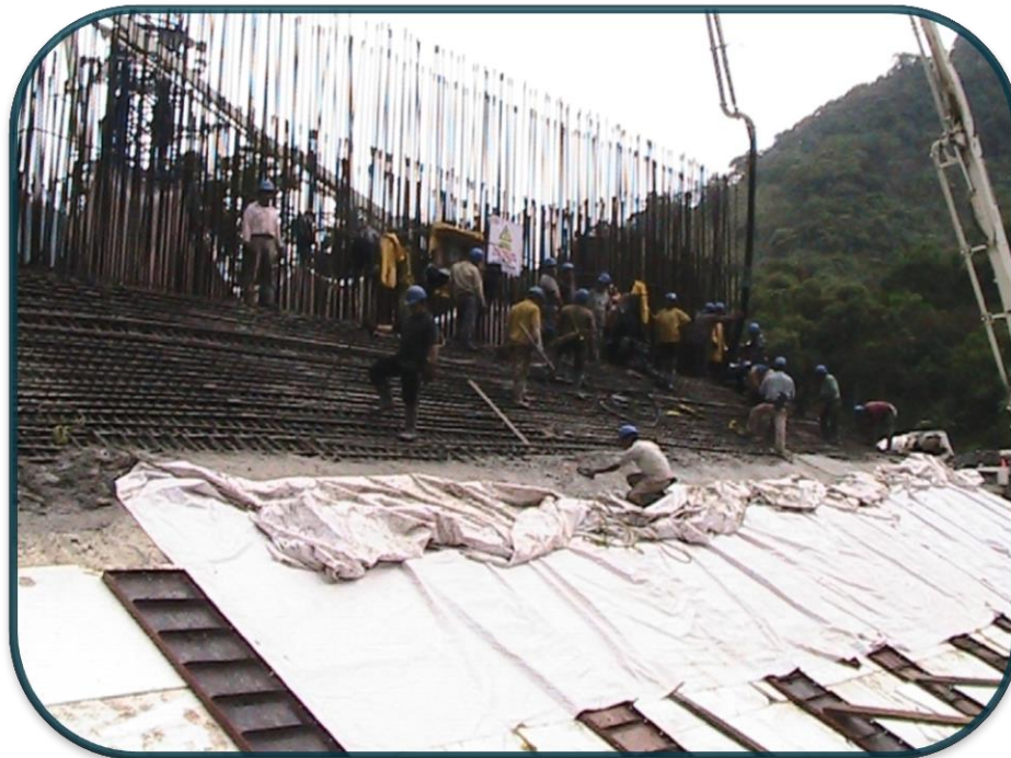
FOTOGRAFIA No.86.-Sobre la membrana de curado y el panel de polipropileno (unicel) se colocaron lonas que mantenía la humedad del colado y no permitió que la lluvia actuara sobre la cara expuesta.
