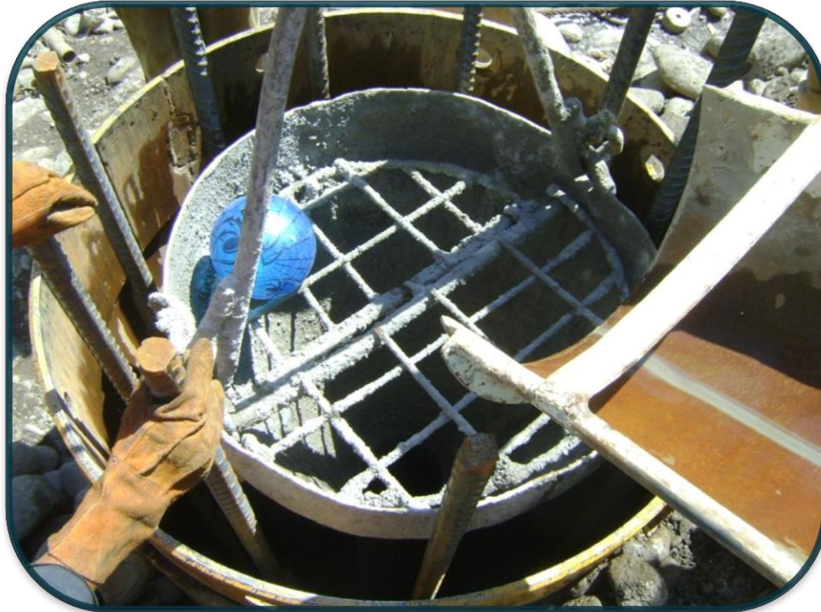
FOTOGRAFIA No.27.-A este tubo se le coloca un pelota que permite que el concreto no se segregue cuando se llena el tubo.
