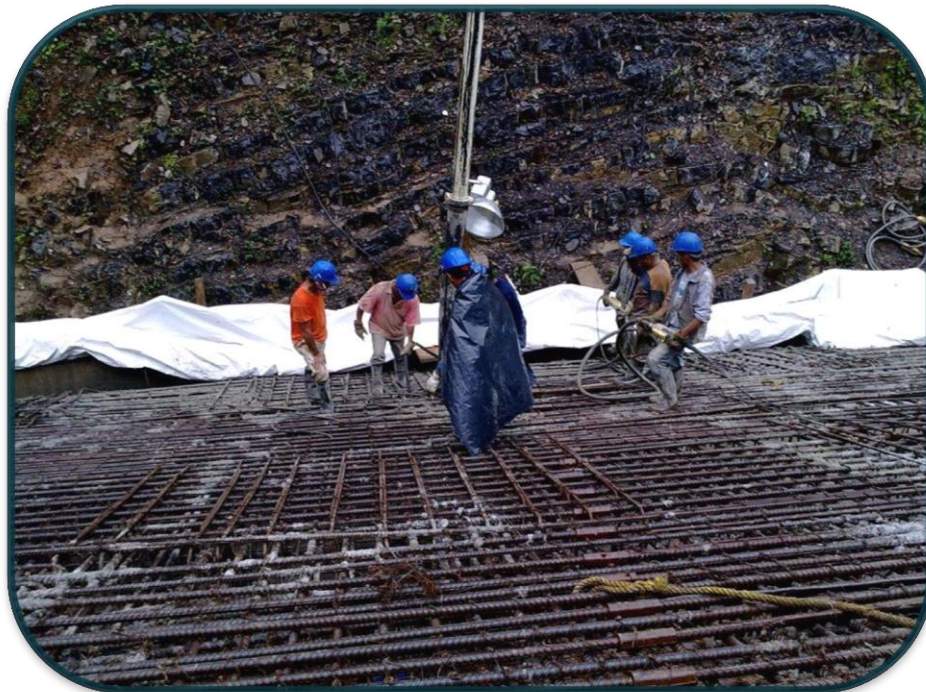
FOTOGRAFIA No.80.-El colado se dio inicio y los equipos de trabajo se repartieron en dos turnos de los cuales al principio una parte de estos estaban dentro de la estructura y otros por arriba.
