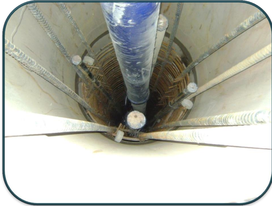
FOTOGRAFIA No.23.- Ya colocado el acero se introduce un tubo tremie que no permite la segregación del concreto vaciado al pilote.
