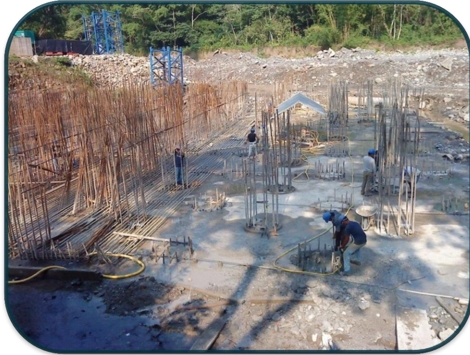
FOTOGRAFIA No.39.-Con la limpieza realizada se nivelaron algunos pilotes que quedaban bajo el nivel de desplante
