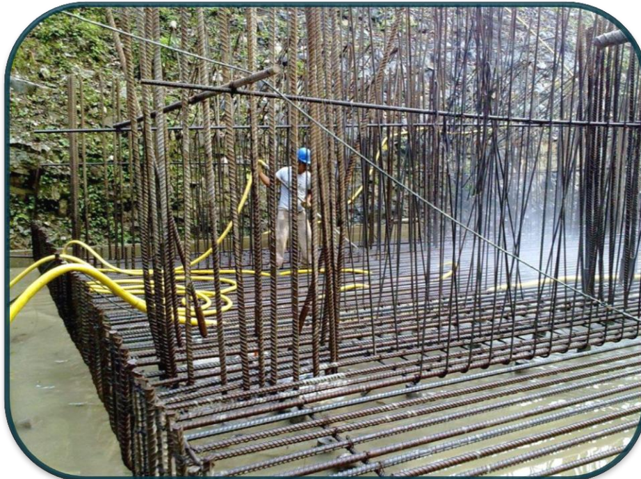
FOTOGRAFIA No.38.- Ya terminados los pilotes se realizo la limpieza del desplante con agua a presión y aire para quitar las impurezas del piso y poder colar la plantilla.
