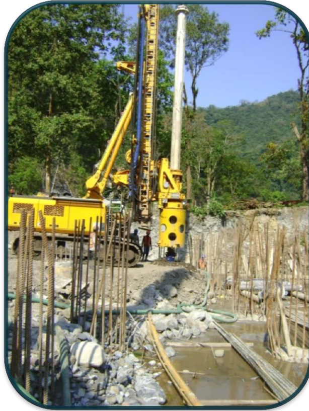
FOTOGRAFIA No.7.- Previo a la excavación se le da trazo topográfico de cada centro de pilote y se verifica su verticalidad constantemente además de que se construye una plataforma de trabajo a la perforadora de 1 m de espesor.
