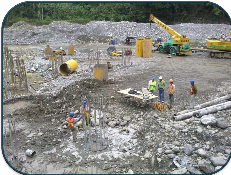
FOTOGRAFIA No.36.-Previo a los estudios se realizaba el descabece y se procuraba tener varios pilotes listos para estudiar el mayor numero posible.
