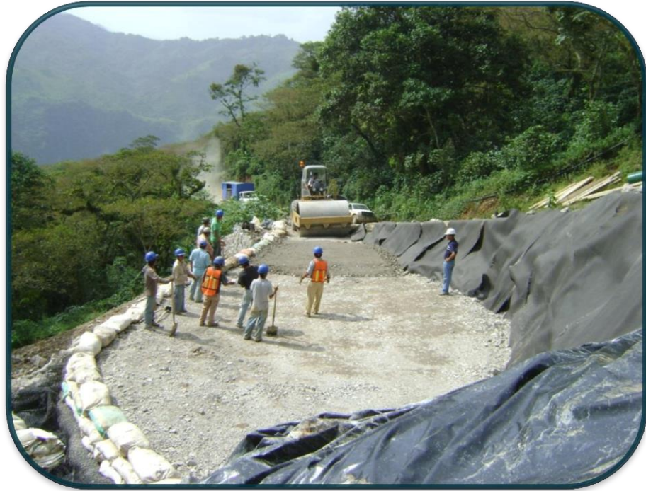
FOTOGRAFIA No.9.-Como ya se menciona se realizaron trabajos de mejoramiento de caminos y ampliaciones de curvas para la facilitación del acceso a los equipos de trabajo.
