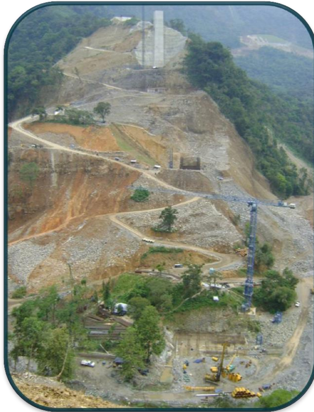
FOTOGRAFIA No.76.-En esta foto panorámica se aprecia el camino de descenso, desde el estribo 1 hasta la pila 4 con un desnivel de 200 m aprox.
