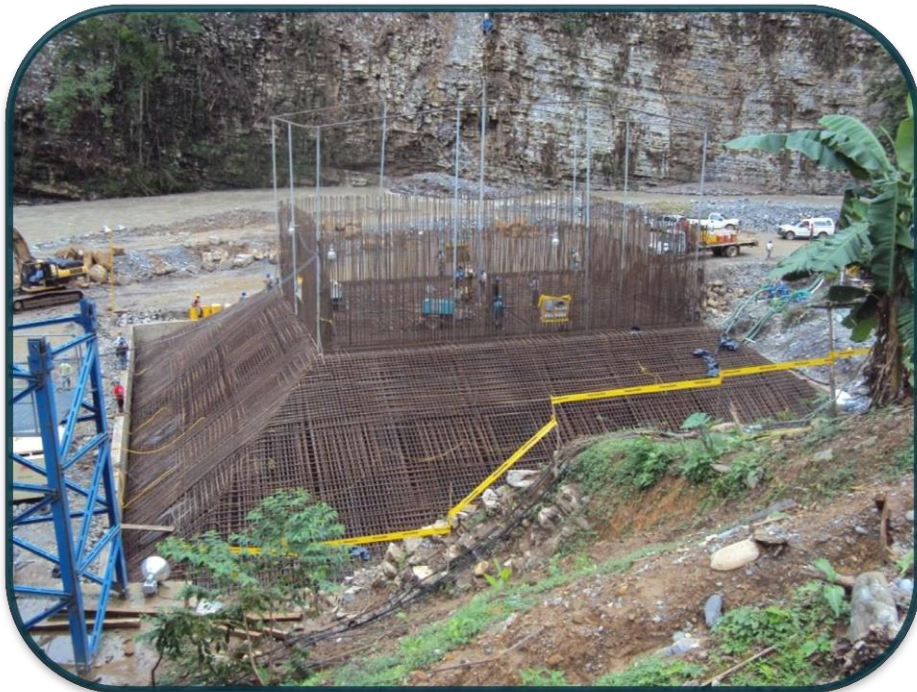
FOTOGRAFIA No.56.-Día a día se vio el avance en la colocación de acero de la zapata.
