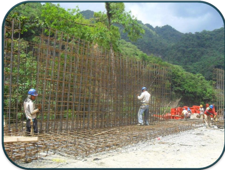
FOTOGRAFIA No.48.-El esqueleto del muro se armo a un lado de la zapata para mayor maniobrabilidad de estos.
