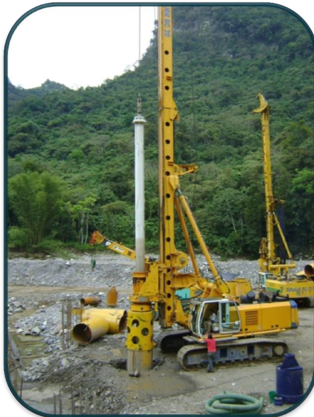
FOTOGRAFIA No.6.-Por cuestiones de rendimiento se utilizaron dos perforadoras de distintas capacidades y en dos turnos.
