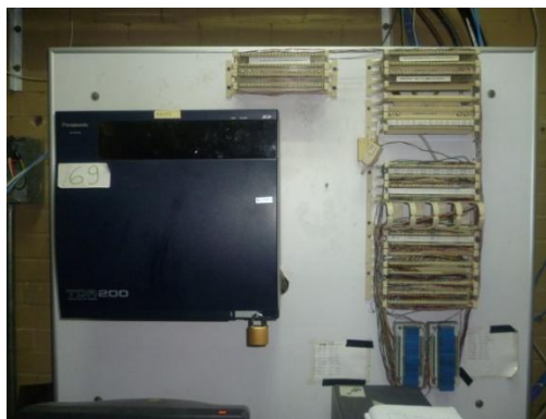
Figura 3.19. Conmutador y regletas para voz.
