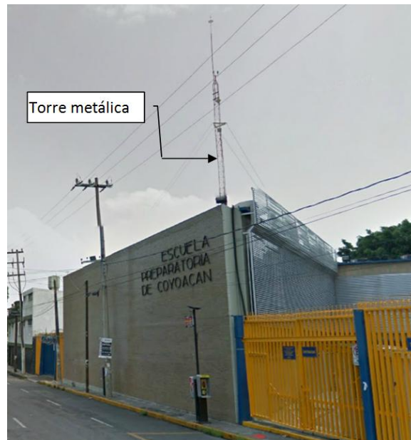
Figura 3.2. Torre metálica para la instalación de antenas.
