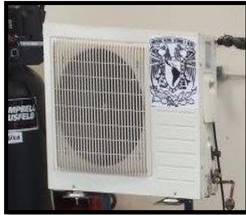
Figura 4. 7 Unidad condensadora del minisplit. 65
