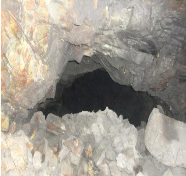
Figura 5-1 Rebaje viejo, carga acumulada 4to escurrimiento.
