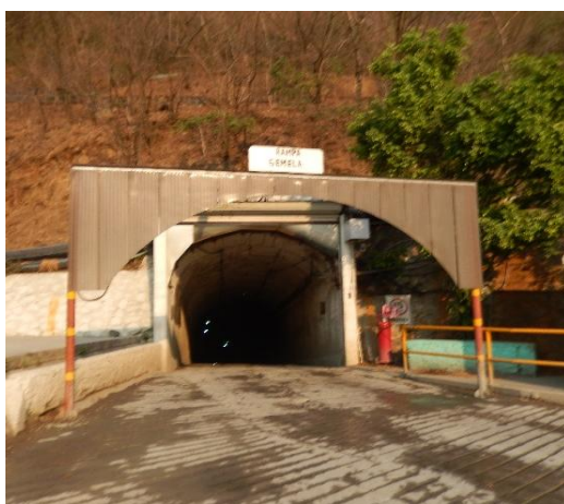
Figura 4-1 Acceso "Rampa Gemela"
