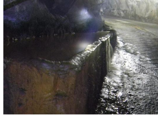
Figura 3-6 Pileta de captación del DAM
