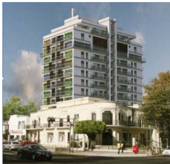
Figura 4.15 Vivienda Vertical Cuatro Vientos
