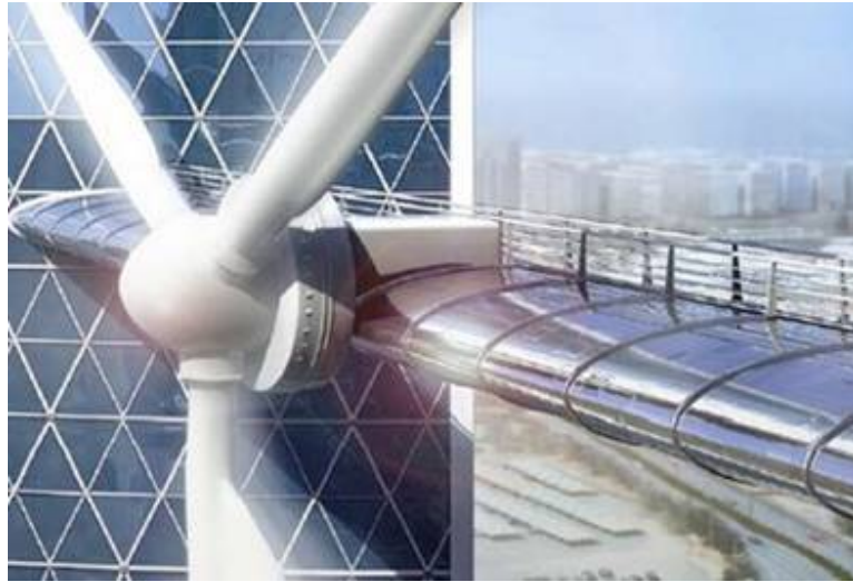
Figura 2.23 Detalle de aerogenerador en edificio
