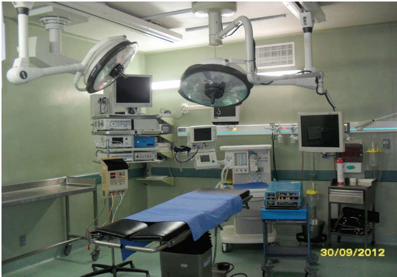
Figura 4. Sala 1 de quirófano del "Hospital Modelo".
