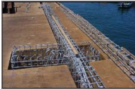
Fig. 4.1 Colocación de acero de refuerzo en obra marítima
