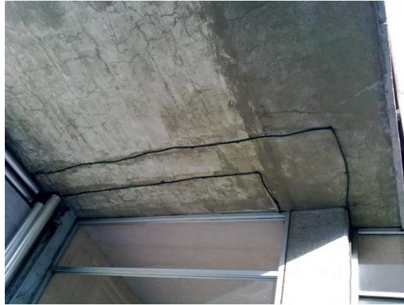
FIGURA 3 CABLE DE TIERR FISICA
