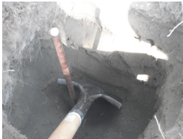
FIGURA 4 COLOCACIÓN DE LA VARILLA
