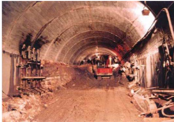
Figura 4.11. Excavación de los hastiales
