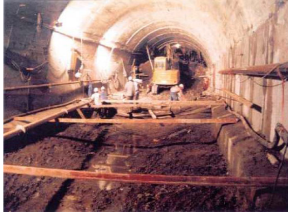
Figura 4.12. Excavación de la cubeta o solera
