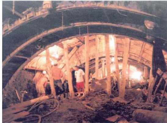
Figura 4.9. Etapa de excavación de la bóveda.
