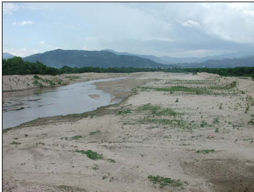
Fotografía 3 Panorámica del río Lagartero en el cruce del pasaje puente Santa Rosa.
