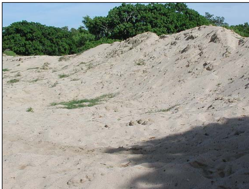
Fotografía 8 Dique recién construido para protección contra inundaciones
