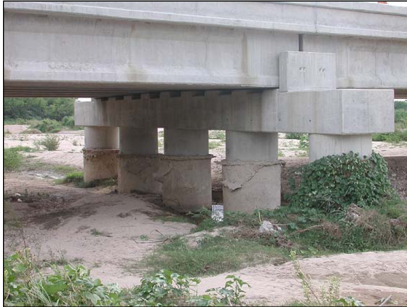
Fotografía 1 Pasaje puente Santa Rosa km 0+300 (río Lagartero)
