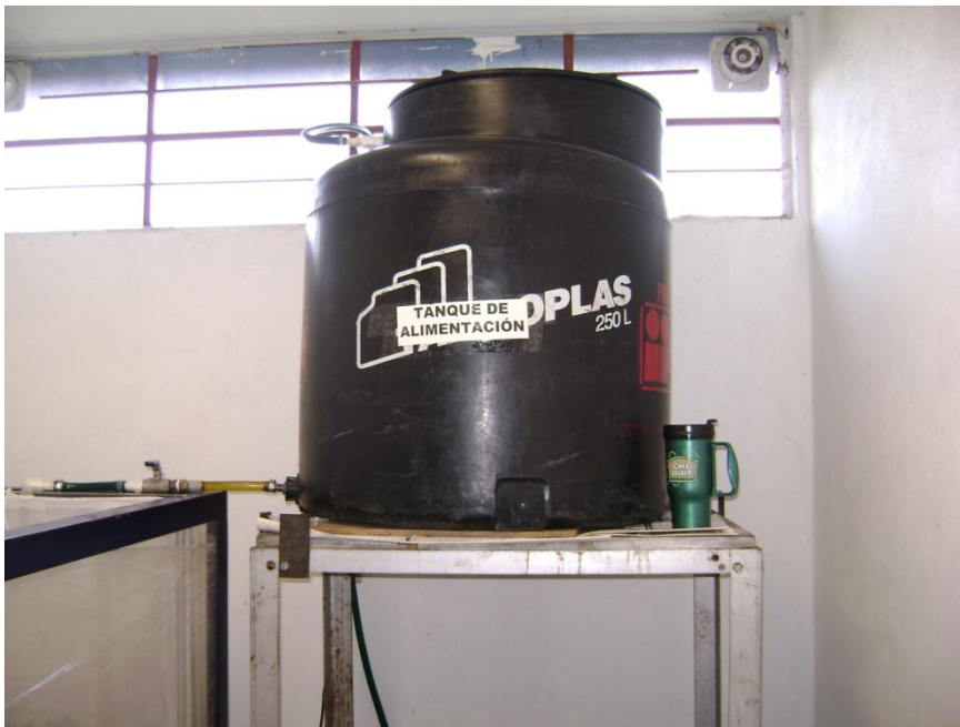
Figura 3.22 Instalación del tanque de alimentación
