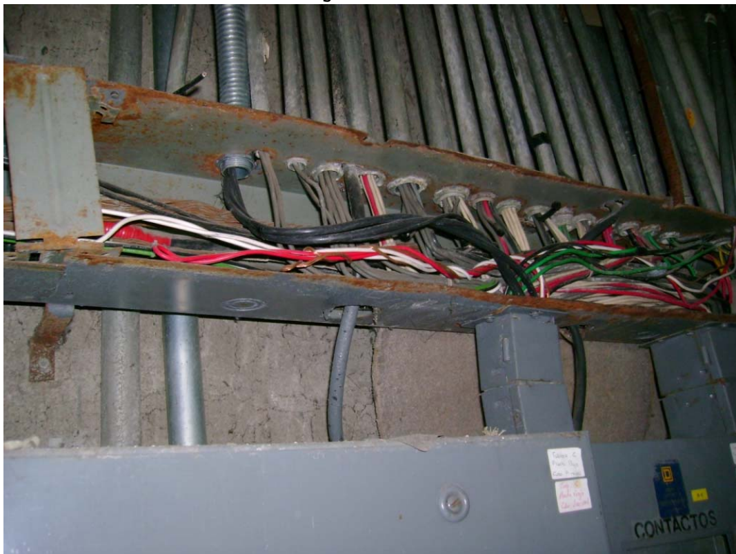
Ducto Panta Baja
