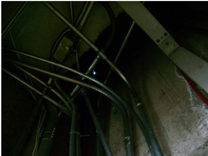
Segundo Nivel (oquedad)
