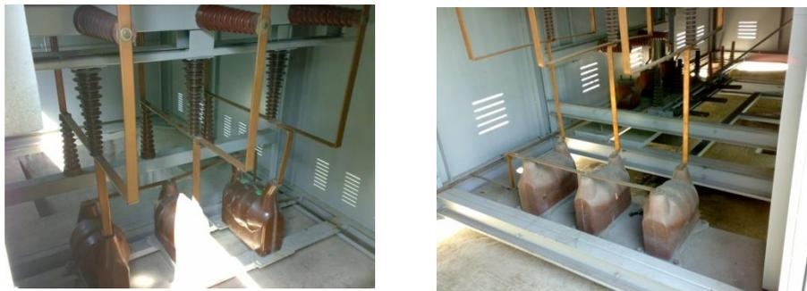
Figura. 3-4 Transformadores de Potencial.
