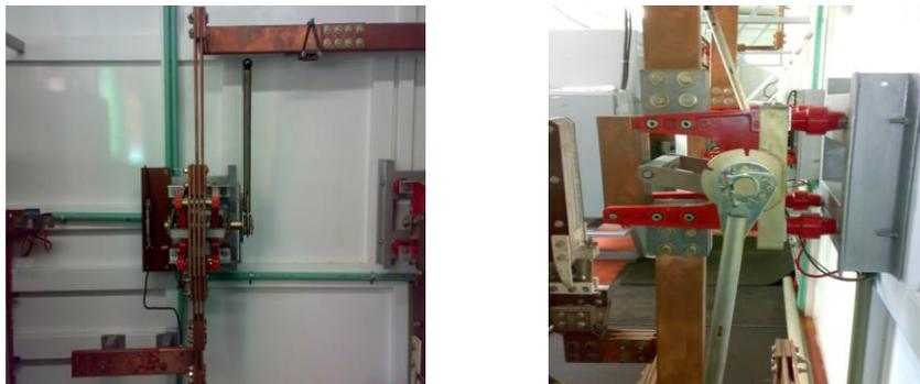
Figura. 3-10 Seccionadores 89N y 89P.
