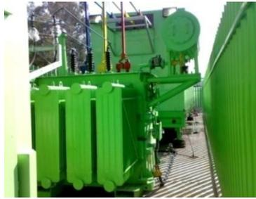
Figura. 2-23 Transformador de Potencia Trifásico de 23 kVca/474 Vca, 2225 kVA y a una frecuencia de 60 Hz.
