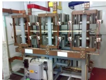
Figura. 2-24 Banco Rectificador de 2500 kVA, 600 Vcd, 2000 Amp. RMS, y 2200 V de pico inverso.
