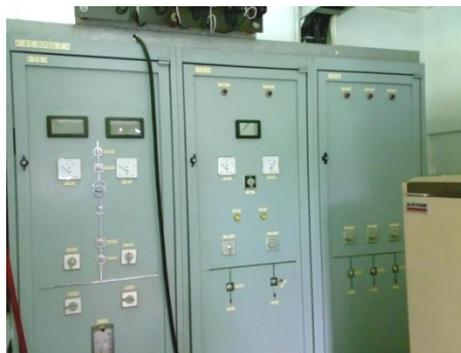
Figura. 2-29 Gabinete de Control, se divide en tres secciones (TG, TD1 y TD2).
