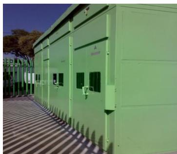
Figura. 2-18 Gabinete de Alta Tensión dividido en cuatro celdas.
