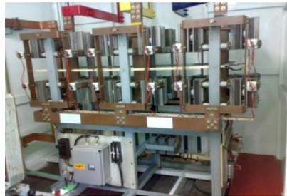
Figura. 2-13 Rectificador JEUMONT-SCHNEIDER de 6 pulsos.
