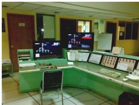
Figura. 2-32 PDC desde aquí se controlan a distancia los equipos principales de las Subestaciones.
