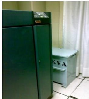
Figura. 2-34 UPS 2000 provee alimentación estática ininterrumpida.
