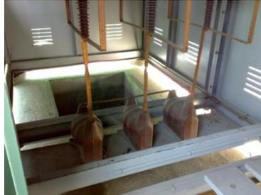
Figura. 2-19 Celda para alojar el equipo de Medición de CFE.
