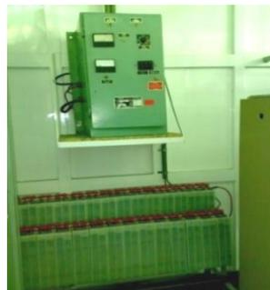
Figura. 2-28 Banco de Baterías de Nickel-Cadmio de 100 Amp/hora, 120 Vcd y Cargador de Baterías con alimentación de 127 Vca, entrega 120 Vcd con 40 Amp. Suministra la corriente necesaria para mantener la carga del Banco de Baterías (flotación).
