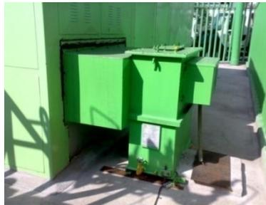
Figura. 2-22 Transformador de Servicio Trifásico de 23 kVca a 220/127 Vca, 30 kVA y a una frecuencia de 60 Hz.
