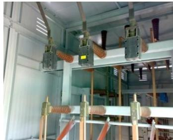
Figura. 2-20 Cuchillas Seccionadoras Trifásicas Generales de 23 kVca.
