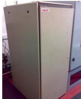
Figura. 2-30 TE-14 manda las alarmas presentes de la subestación a PDC.
