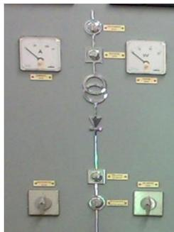
Figura. 2-12 Diagrama Unifilar de la Subestación del Gabinete de Control.
