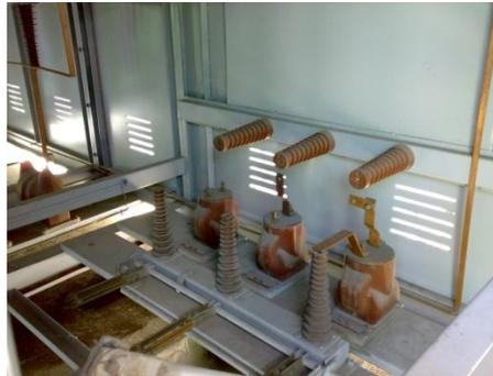
Figura. 3-3 Transformadores de Corriente.
