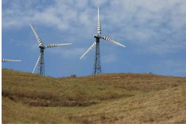
**Figura 4.7** Aerogeneradores con los álabes pintados con un patrón visible en Altamont Pass, California.
