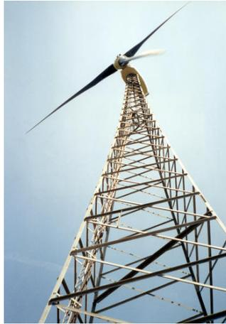
**Figura 4.4** Deben evitarse las torres de elementos estructurales.
