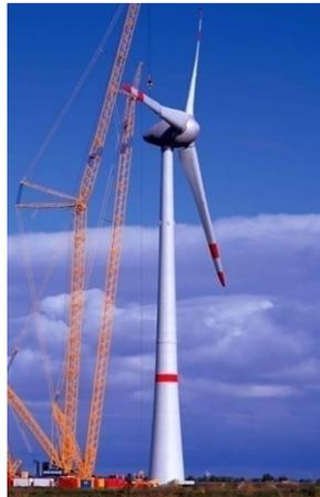
**Figura 2.9** Turbina eoloeléctrica Enercon-E126 de 6 MW de capacidad<sup>13</sup>.
