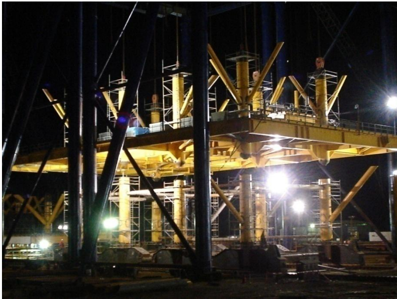
Ilustración 20. Colocación de la cubierta inferior sobre las columnas
