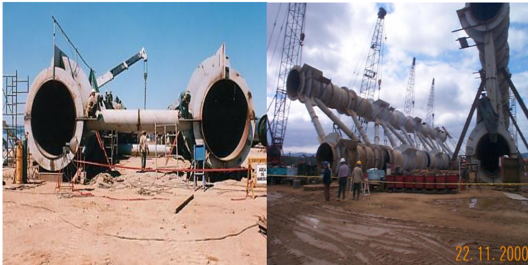
Ilustración 8. Izaje de marcos de una subestructura
