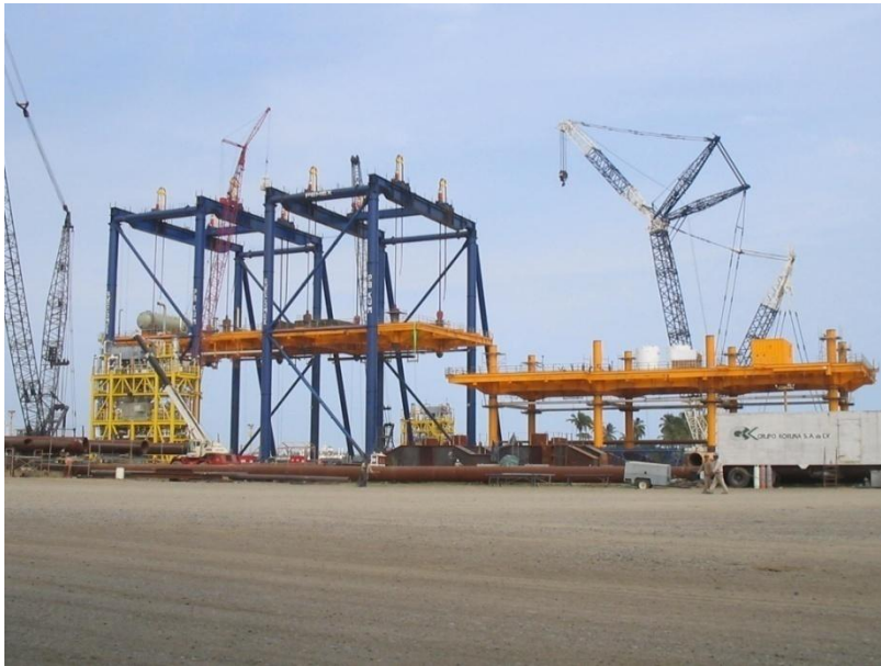
Ilustración 17. Izaje de la cubierta superior para su colocación
