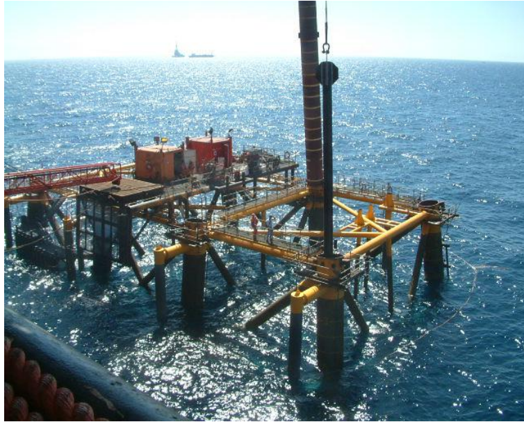
Ilustración 6. Hincado de pilotes
