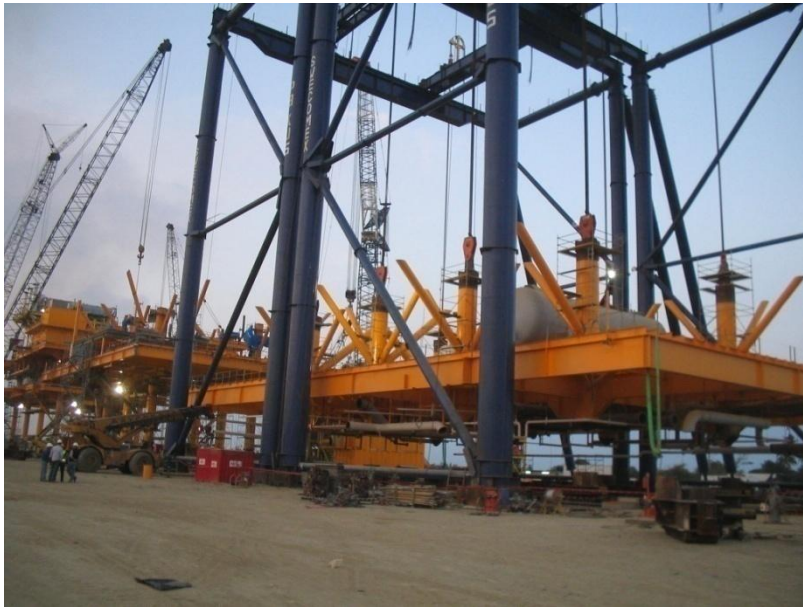
Ilustración 21. Izaje de la cubierta intermedia
