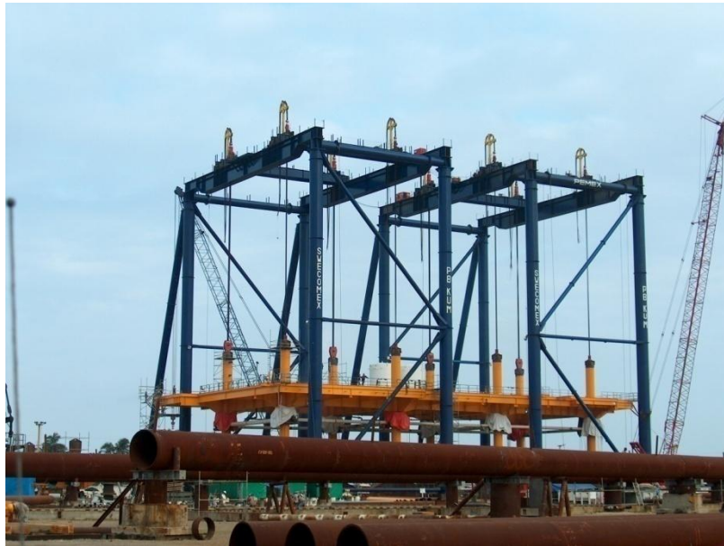
Ilustración 5. Pórticos simétricos de estructura metálica
