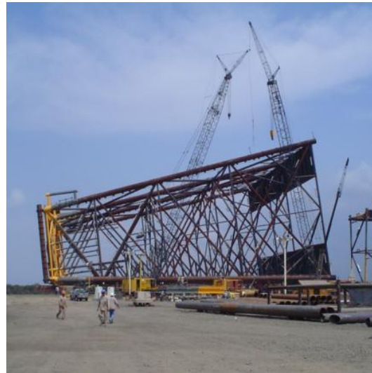
Ilustración 7. Subestructura apoyada sobre correderas
