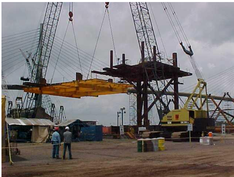
Ilustración 33. Izaje de la cubierta
