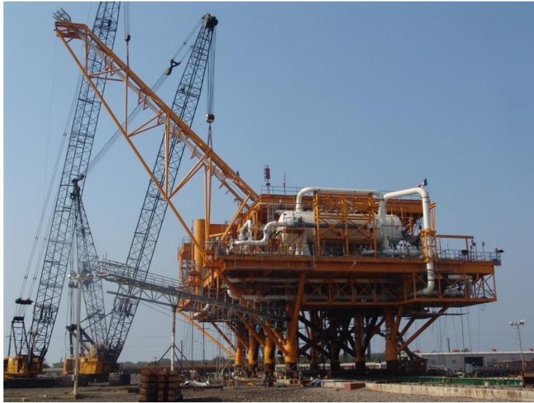
Ilustración 14. Superestructura terminada en un patio de fabricación
