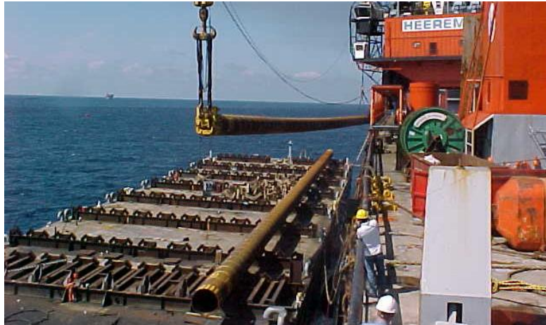
Ilustración 22. Chalán de transporte de pilotes
