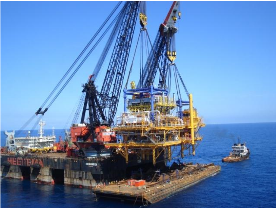
Ilustración 25. Izaje de una superestructura para su instalación
