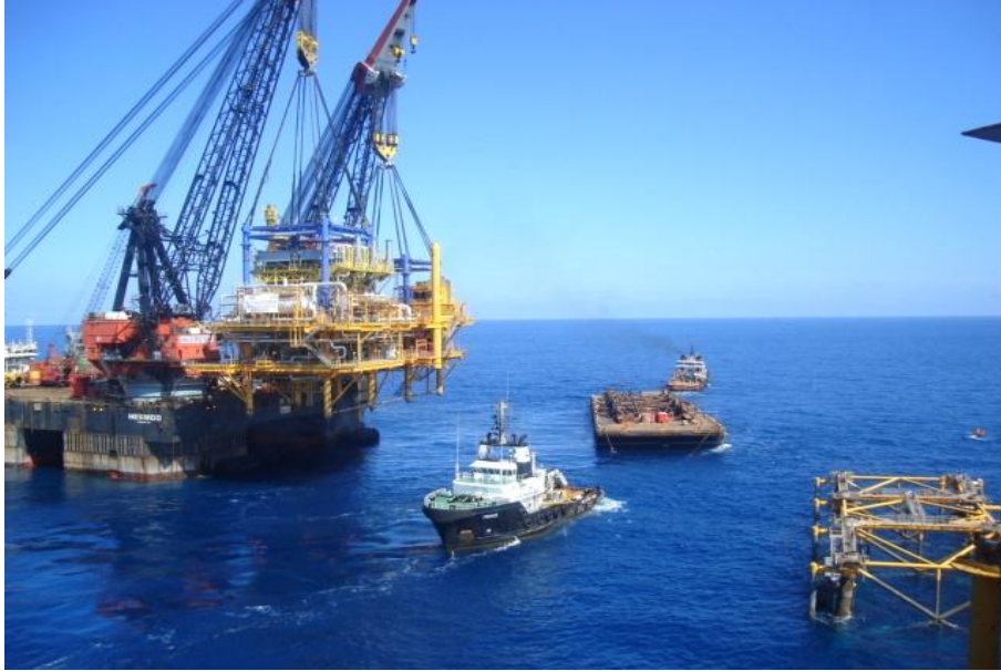
Ilustración 26. Aproximación de barco grúa a la subestructura
