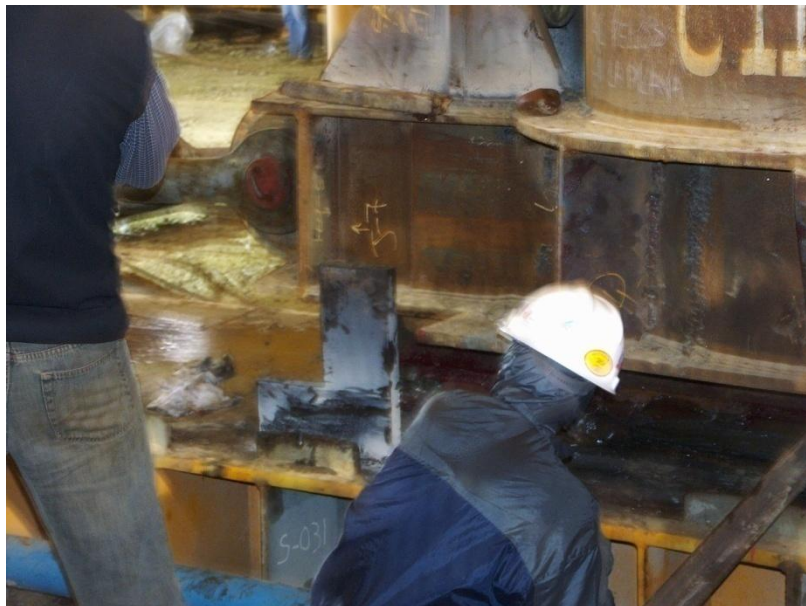
Ilustración 15. Tope pa colocación de estructura
