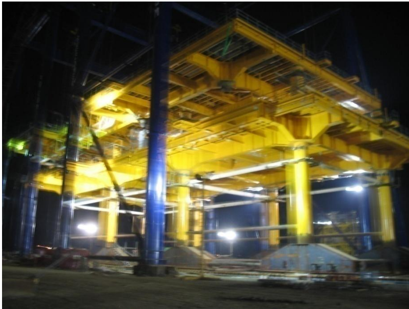
Ilustración 18. colocación de la cubierta superior en su posición final
