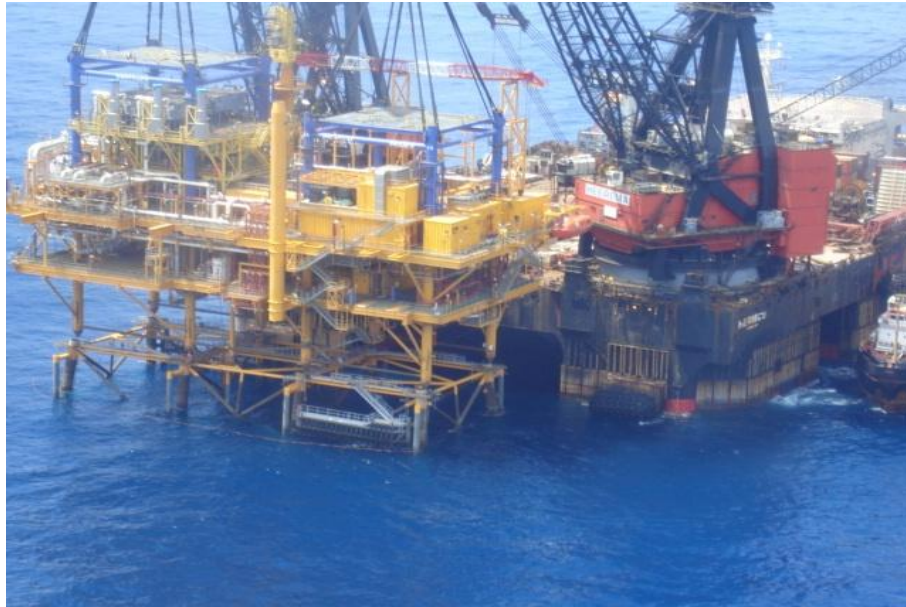
Ilustración 27. Instalación de la superestructura en su subestructura
