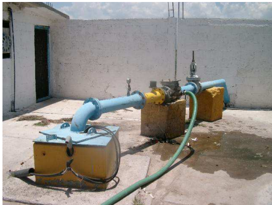
P3-2 Pozo Miravalle
