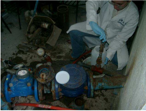
P1-1 Pozo Tezoquipa
