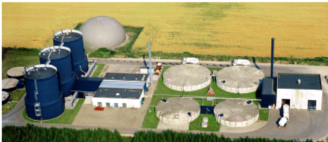
Figura 3.10 Planta de biogás en Dinamarca [5].
