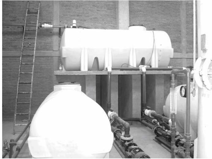
Figura 5.9. Separador trifásico de tres etapas.
