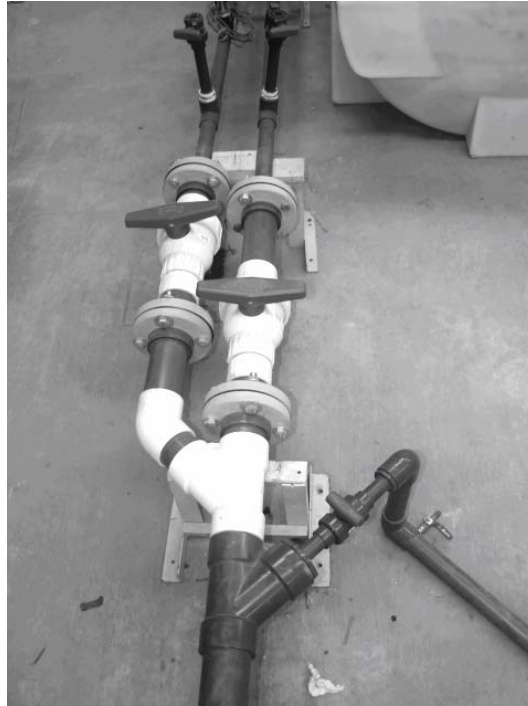
Figura 5.4. Punto de producción de la mezcla trifásica.
