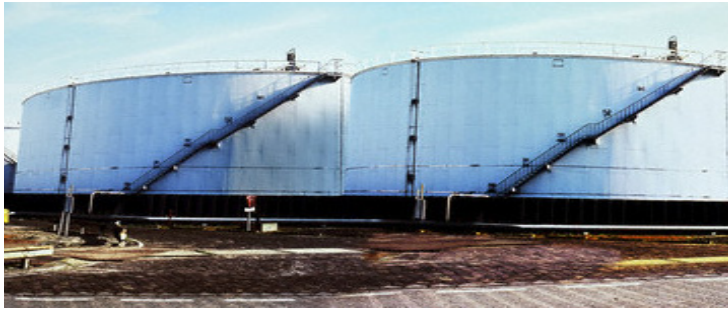
Fig. 5.96 Tanque de techo cónico.
