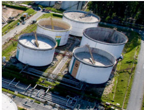
Fig. 5.97 Tanque de techo flotante.
