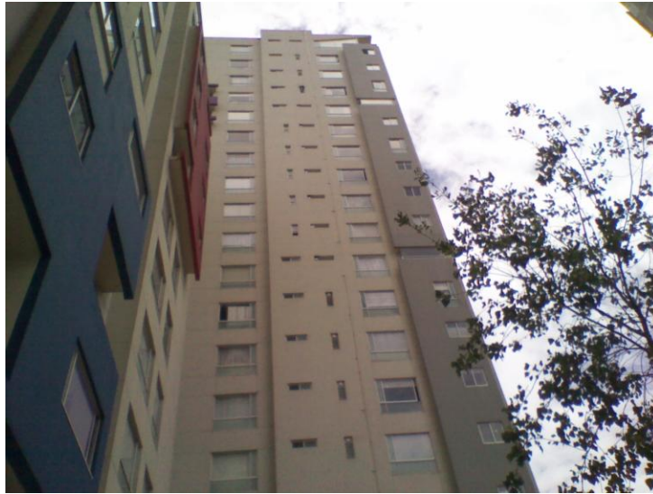
Fig. 3.9. Torre del conjunto habitacional.
