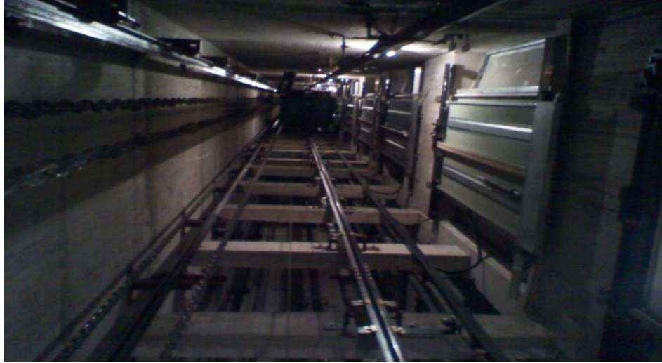
Fig. 3.10 Cubo del ascensor.
