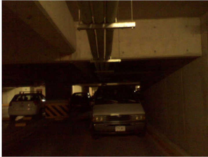
Fig. 3.12 Verificación de altura.
