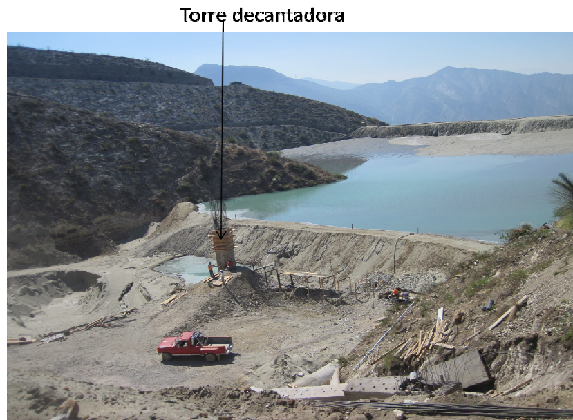
FIGURA 2.12. Sistema decantador drenante
