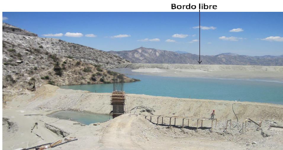
FIGURA 2.10. Cortina contenedora (arriba) y bordo libre (abajo), depósito para jales minera La Negra
