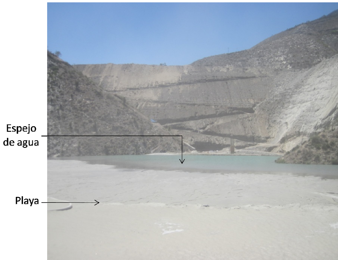
FIGURA 2.11. Vaso de almacenamiento depósito para jales minera la Negra
