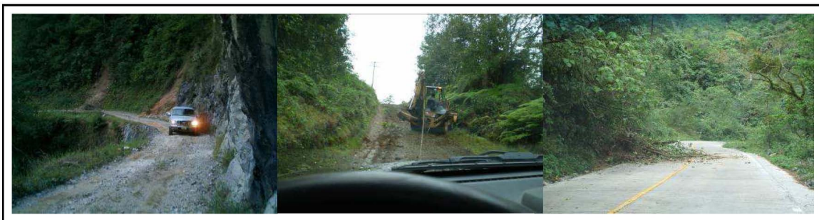
Figura 4.16. Cruce de barranca, remolque de vehículo y derrumbe de talud
