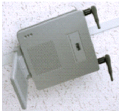
Imagen 3.3.2.1 Posición correcta en techo
