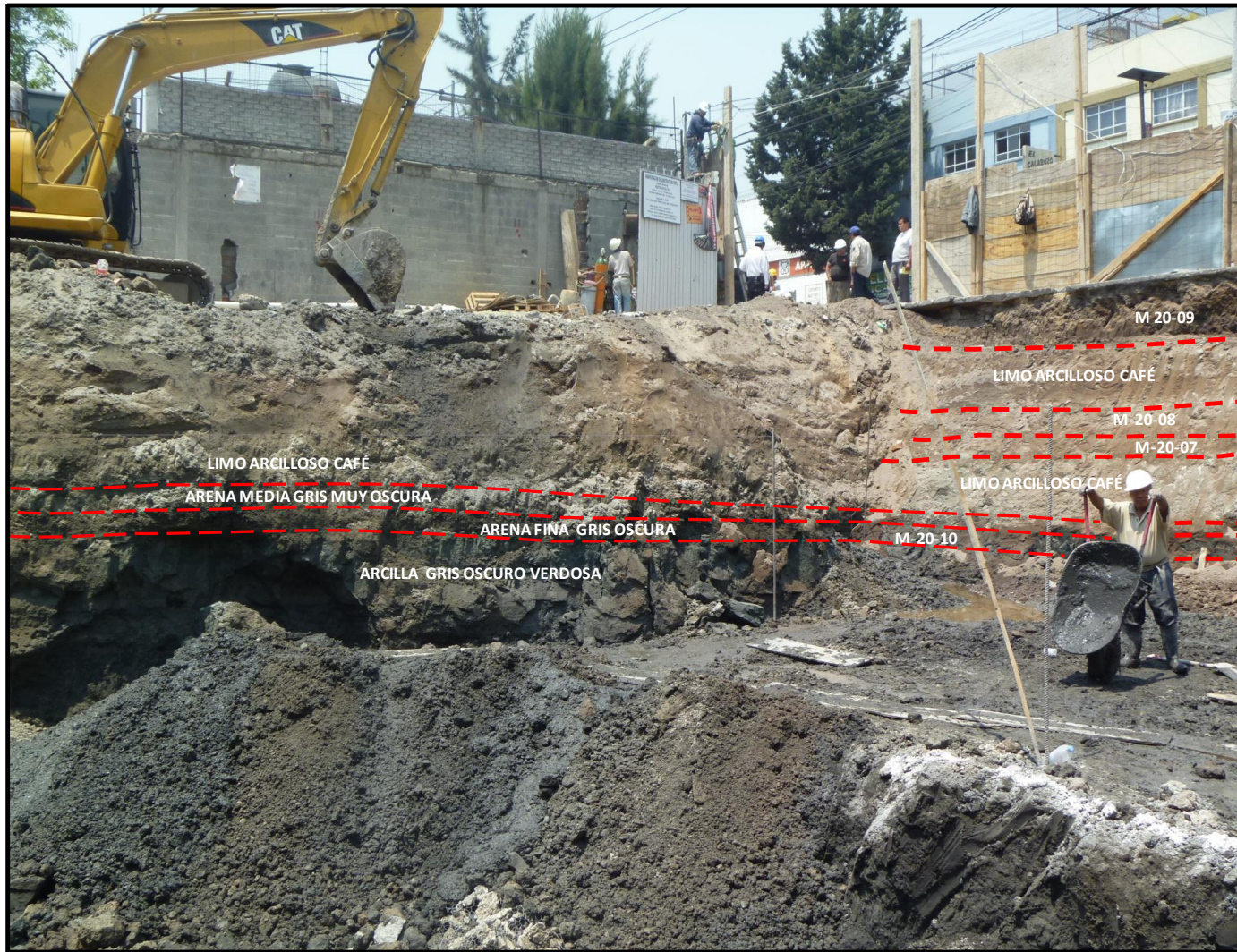
Figura 9.- Perfil que muestra los diferentes horizontes de limos, arenas y arcillas. Ubicado en un predio a 32m al sur, de la unidad habitacional La Concordia. (Tomada de Zamudio-Ángeles et al. , 2010)
