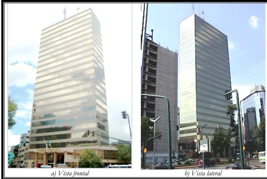
Figura 3.14. Vistas del edificio Reforma N° 51
