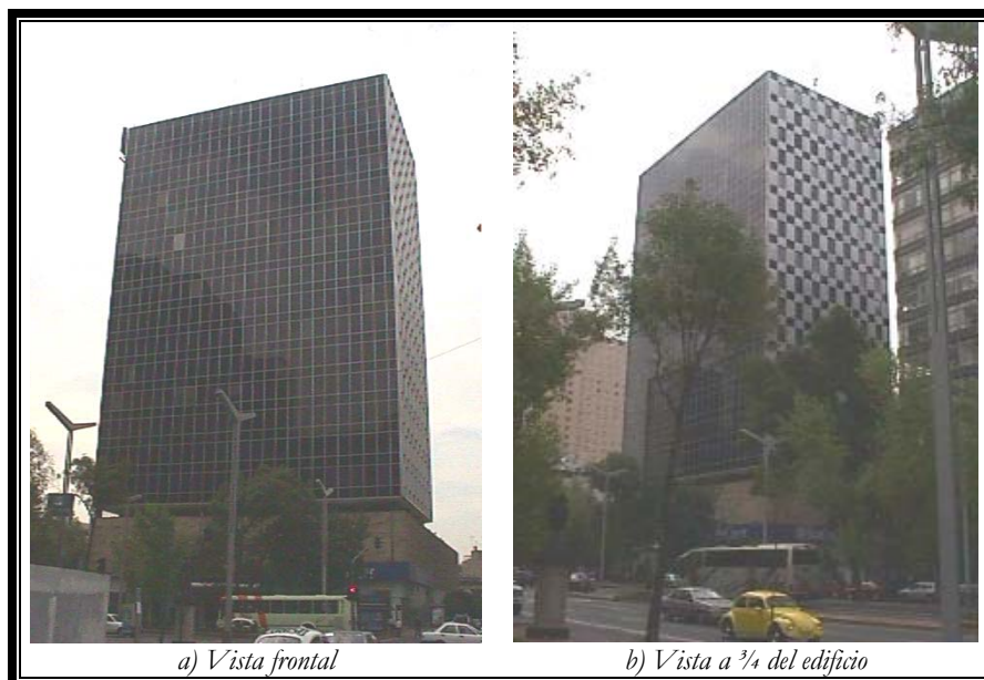
Figura 3.11. Imágenes del edificio
