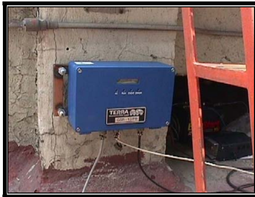
Figura 4.12. Instrumentación del Edificio Reforma 116
