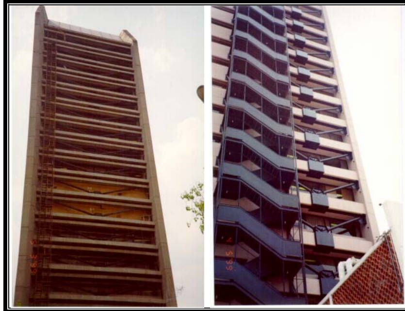
Figura 3.4. Detalles del reforzamiento estructural del edificio Exconasupo.
