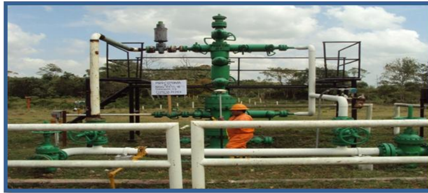
FOTO No. 12 – Poaicionamiento de Pozos Petroleros
