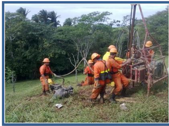
Foto No. 13. Perforación con Inyección de Agua.
