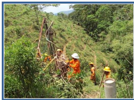
Foto No. 14. Perforación con Aire, Zipper II.
