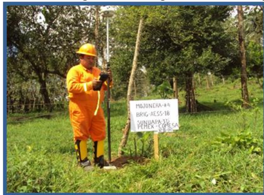
Foto No. 9. Plantado y Posicionamiento de Mojoneras.
