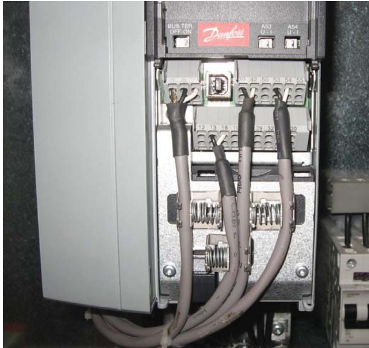
Figura 2.9 Fotografías de un convertidor de frecuencia instalado.
