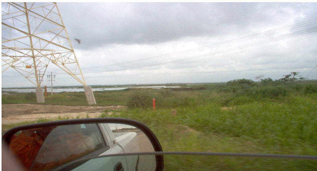
Fotografía 7.2.1. Se muestra la zona pantanosa y junto a ella una torre eléctrica a la cual le han colocado suelo de relleno en su base, este suelo es un material areno-arcilloso, muy inestable. Esta fotografía fue tomada en la “Refinería Lázaro Cárdenas”.
