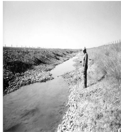
Fotografía 3.2.1 Muestra dispersión de arcillas en el talud de un canal.
