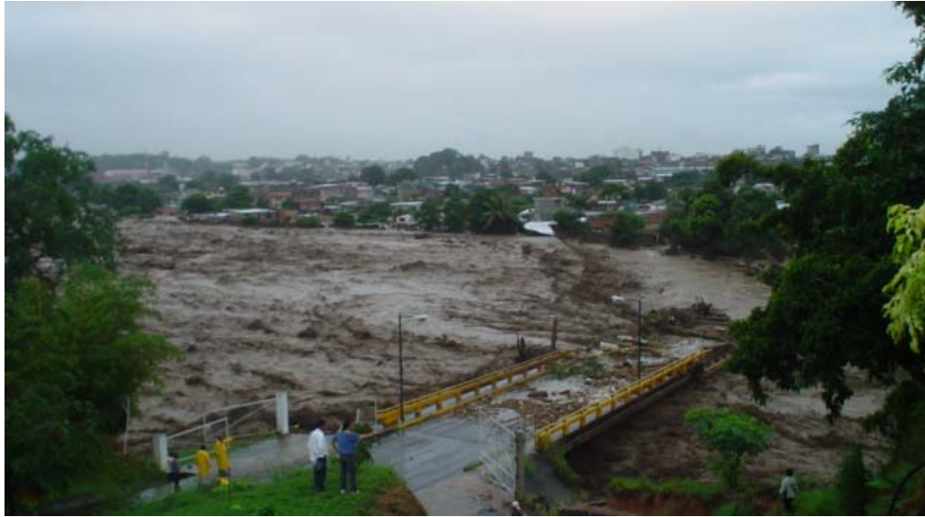
Figura I.2 Transporte de altas concentraciones de sedimento, Puente Flamboyanes (oct 2005)
