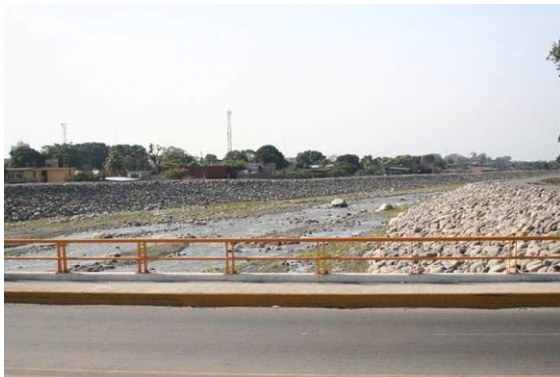
Figura I.9 Bordos de protección y cauce rectificado, Puente Coatán (2007)
