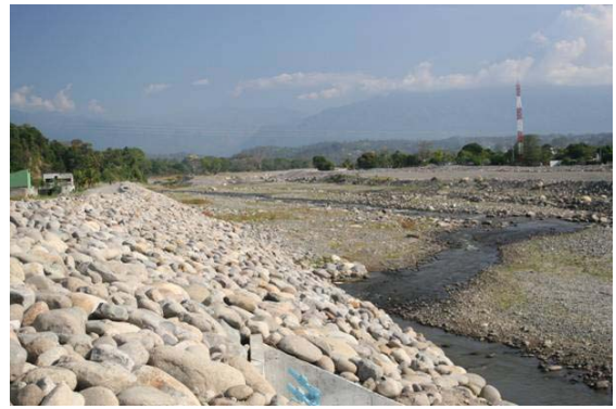
Figura I.9 Bordos de protección y cauce rectificado, Puente Coatán (2007)
