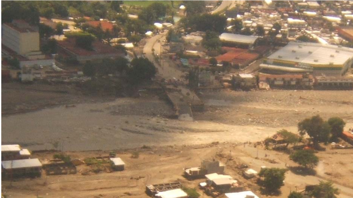
Figura I.4 Restos del Puente Coatán después de la avenida de octubre de 2005
