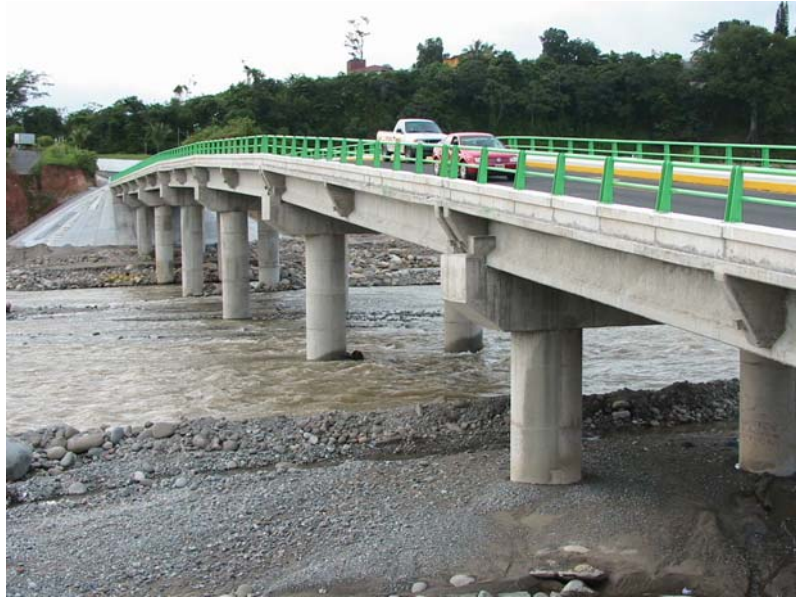
Figura I.10 Nuevo Puento Flamboyanes (feb 2006)
