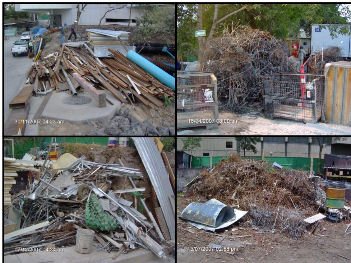
Figura 3.6: Almacenamiento de la chatarra.
