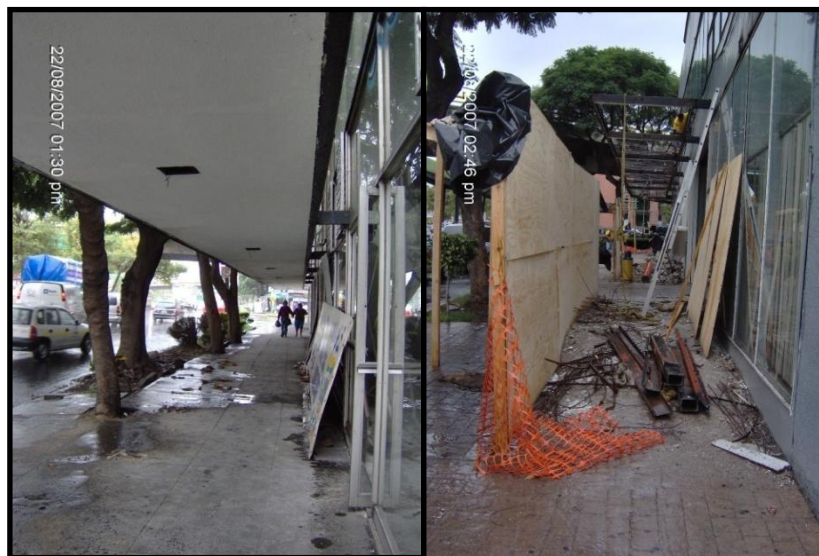
Figura 3.4: Edificio de Oficinas remodelación Marquesina.
