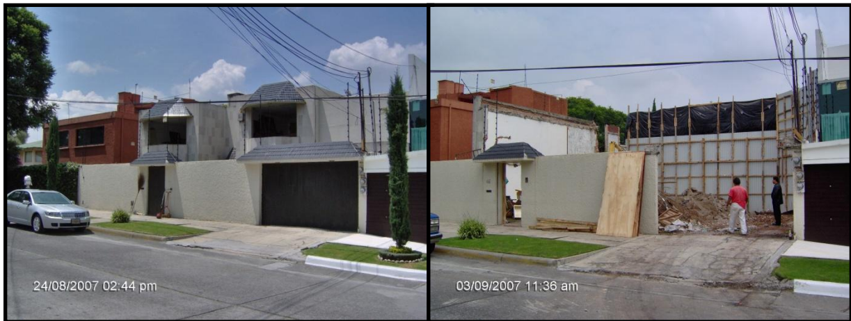
Figura 3.3: Vivienda Residencial de demolición.
