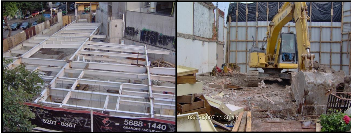
Figura 2.2: Proceso de construcción (Coyoacan, Distrito Federal) y demolición (Ciudad Satélite, Estado de México).
