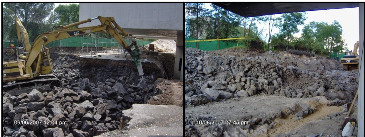
Figura 3.20: Generación de residuos de excavación.
