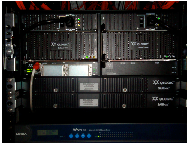
Figura 5-4. Se observan en la parte superior el switch de fibra óptica de 96 puertos modelo 9600, debajo de este se observan los dos switch de 16 puertos modelo 1600.
