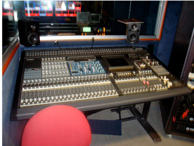
Figura 3-3. En la cabina de audio se monitorea y se ajustan los niveles de audio antes y durante la grabación.
