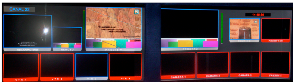
Figura 3-5. Configuración dada al multipantalla para poder observar los diferentes equipos que están grabando y/o reproduciendo.
